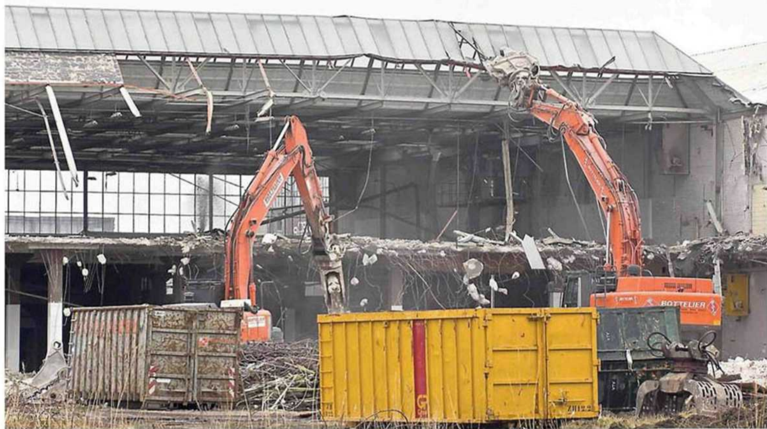
De sloop van vier originele Bruynzeelhallen is in volle gang.
