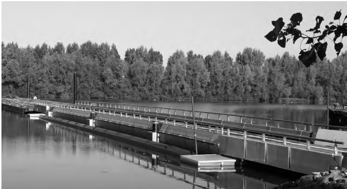
Afbeelding 1, Het prototype drijvende weg te Hedel bij 's-Hertogenbosch
