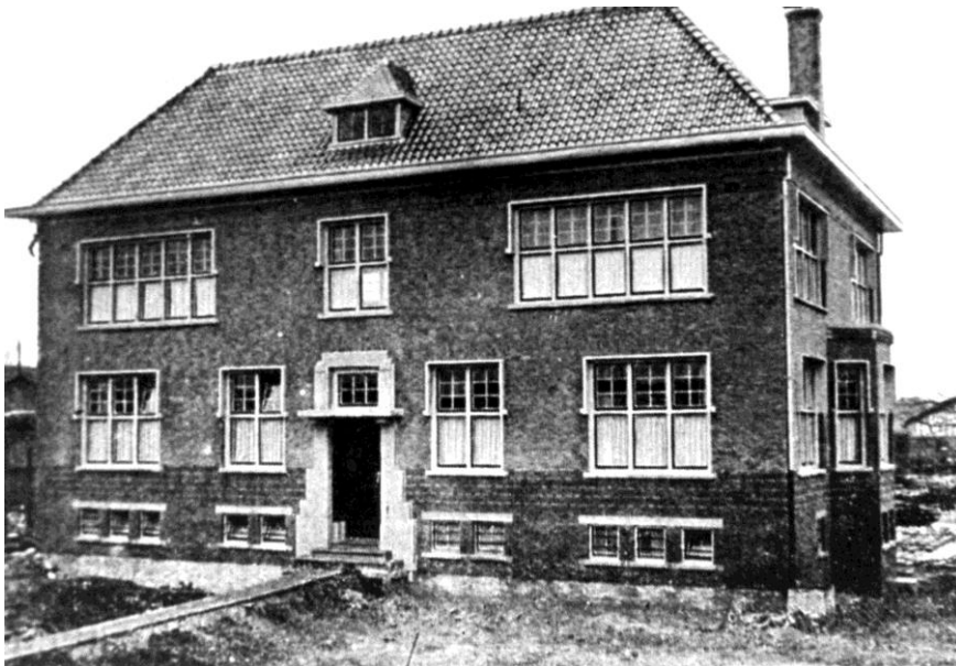
Bouw kantoor Dekker Dekkers Houthandel nv Zaandam Opname: ± 1930
