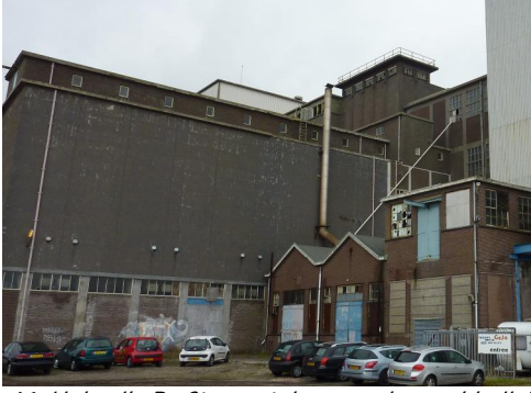
61. Links silo De Ster met daaraan de maalderij; Foto: IvT
