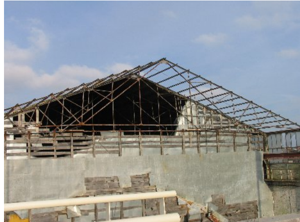
Wandconstructie met verstijvingen en draagbalk loopkraan De top van de hal met polonceauspanten en de noodmuur
