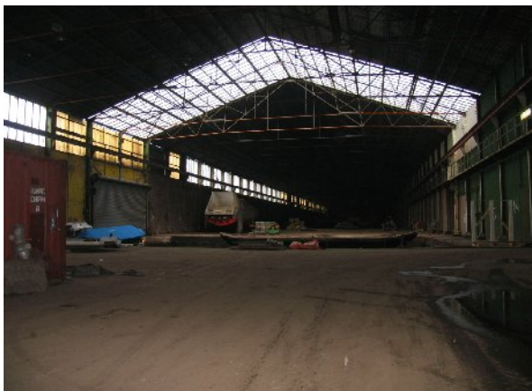
Haven gezien in noordelijke richting met glazen dakvlak
