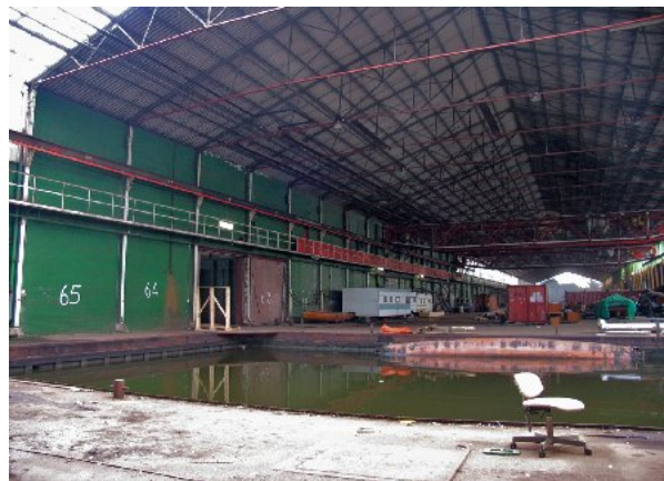
Haven met oostgevel en doorgang naar hal 32
