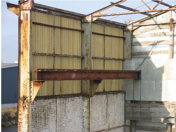
Wandconstructie met verstijvingen en draagbalk loopkraan De top van de hal met polonceauspanten en de noodmuur
