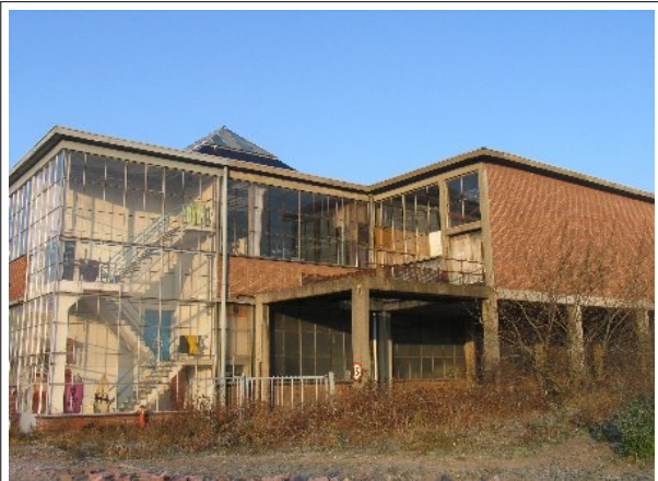
Trappenhuis hal 51, met deur tussenverdieping, deur 1e etage en bordesje bij het vluchtluik naar het dak. Rechts de uitbouw met laadvloer
