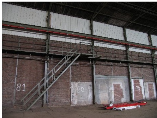
De oostgevel met dichte vensters en deuren vanwege de aansluiting van het kantoor; verder de loopbrug en kraanrail
