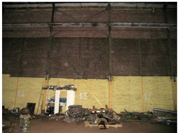
De oostgevel met de stalen gevelconstructie bij een schoor
