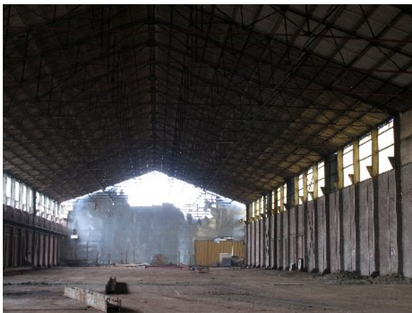
Het zuidelijkste deel van de hal is lichter door de vensters aan beide zijden; aan het eind de tijdelijke halfopen gevel
