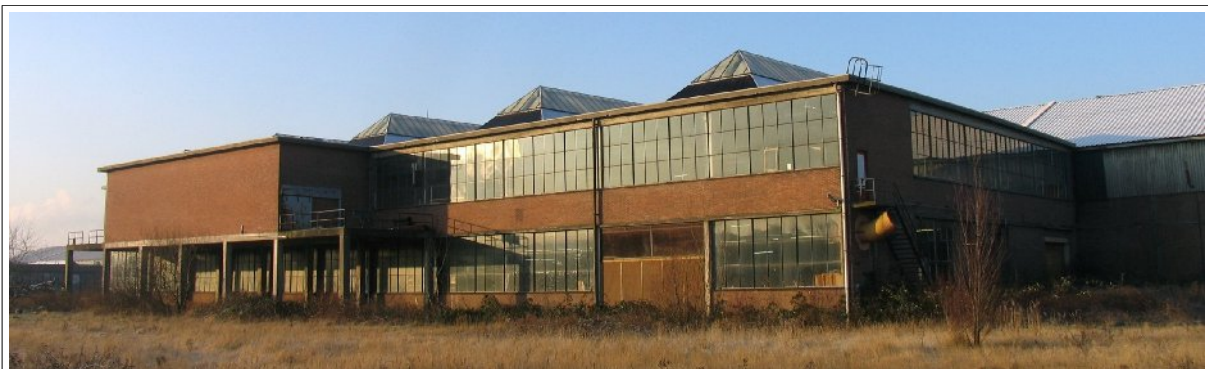
De oostgevel met de aanbouw met laadvloer en noordoostelijke hoek met brandtrap vanaf het dak en 1e etage;
