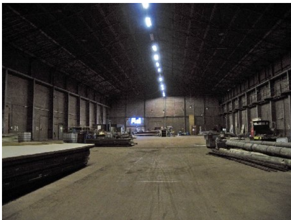
Noordelijke deel van de hal . In dit deel zijn de stalen kolommen links tegen en rechts in de wand verwerkt
