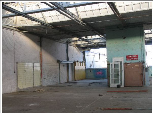
Noordwesthoek van de bovenverdieping met lift en vluchtweg naar hal 33 in de hoek
