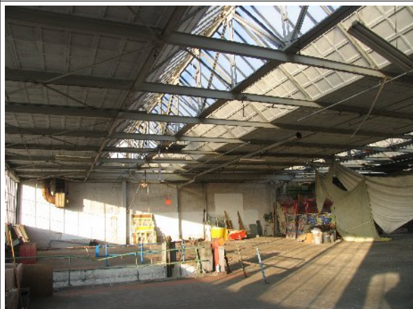
Dakdragende constructie en lichtkap op de bovenverdieping
