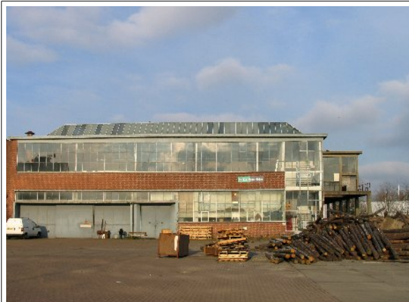
Voorgevel met de grote deuren links die over de hele breedte open kunnen
