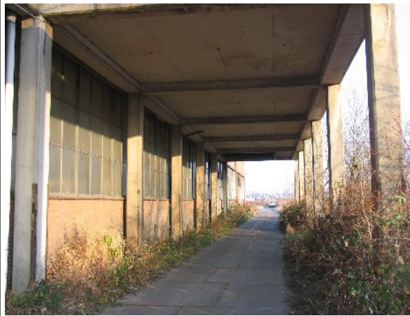
Betonnen onderdoorgang bij de uitbouw
