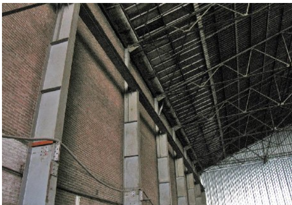
Aansluiting van de staanders west op rail en dak
