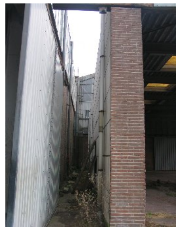
De ruimte bij de aanbouw en hal 32; achterin hal 33
