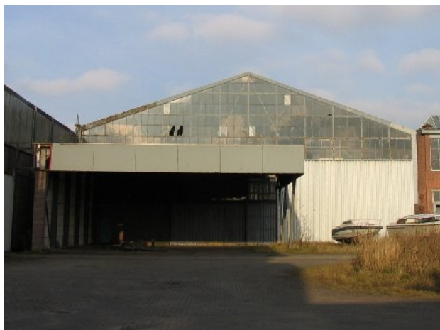
Voorgevel (zuid) van hal 33 met aanbouw
