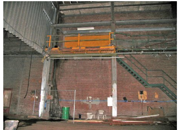
De vluchtweg vanuit bovenverdieping van hal 51
