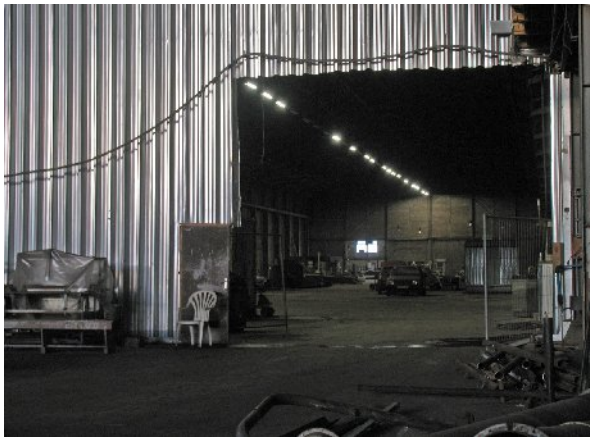
Scheidingswand en doorgang halverwege richting noord
