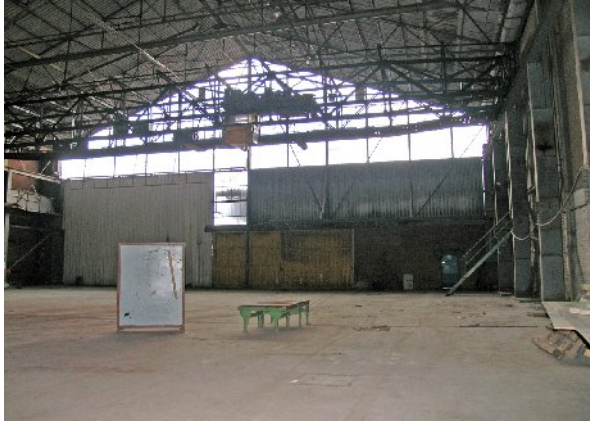
Binnenzijde van de zuidgevel met grote loopkraan
