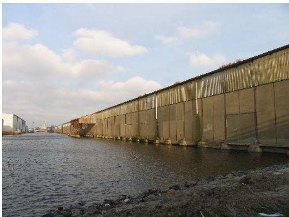
De gehele westgevel; de bepleistering laat de vakwerkindeling vrij; de deuren zijn dichtgezet
