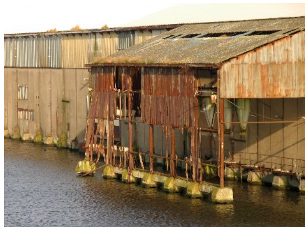
Het ijzeren afdak met de silomonden aan de westgevel
