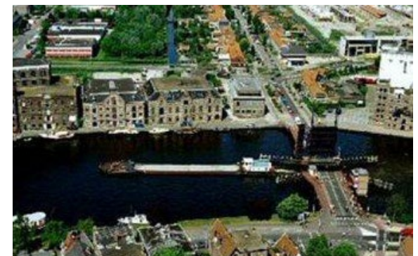
Passage schip ter plaatse van brug
