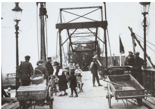
Bouw van het beweegbare gedeelte van de Zaanbrug, 1926
