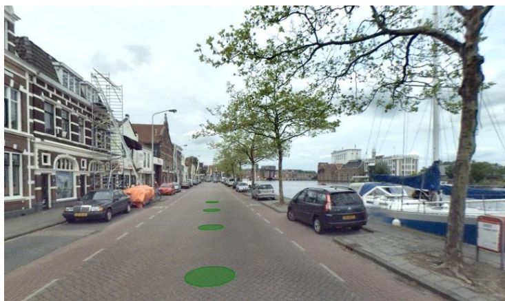
Figuur 2.5: foto huidige situatie Zaanweg ter hoogte van Lassiestraat (Cyclomedia)
