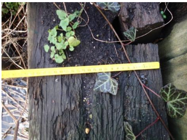
Figuur 4.11: Gordingbalk ingesnoerd 2 – 10 mm.
