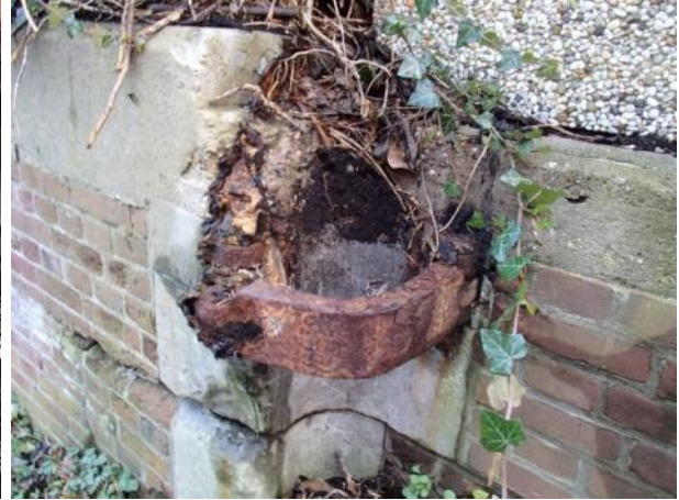
Figuur 7.14: Restanten van een halsbeugel in het bovenhoofd
