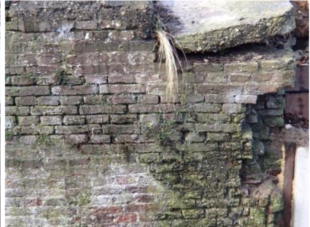
Figuur 7.2: Metselwerkschade bij het benedenhoofd westzijde
