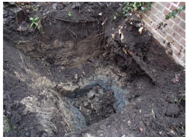
Figuur 7.6: Inspectieput A
