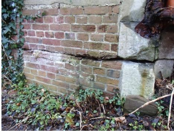
Figuur 7.13: Scheuren in natuurstenen slagstijlen en metselwerk van het bovenhoofd
