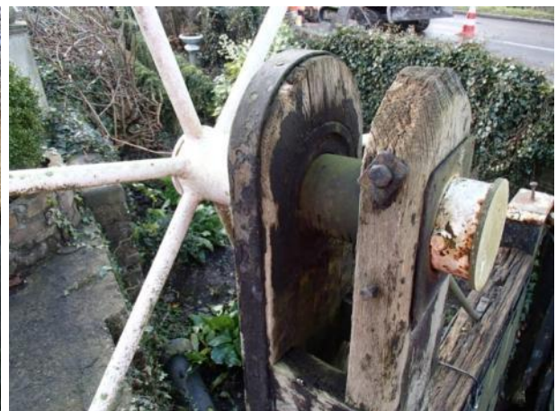
Figuur 7.18: Detail kaapstander, houtaantasting en corrosie van ijzeren banden
