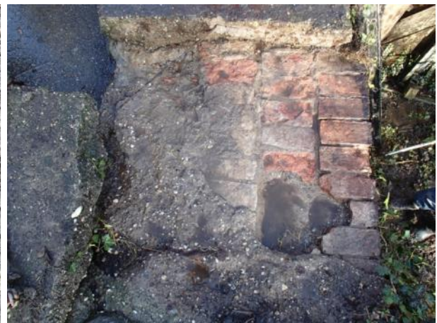
Figuur 7.10: Metselwerk onder de betonnen dekplaten in redelijke staat
