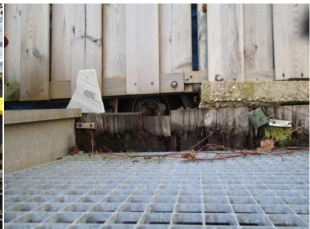
Figuur 4.10: Ingesnoerde/beschadigde kopse kanten van grondkerend scherm.
