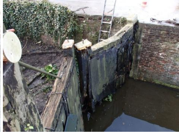
Figuur 7.20: De bovenregel is hersteld met beton, zie ook restanten van ijzeren beplating aan de zijde van de Enge Wormer.
