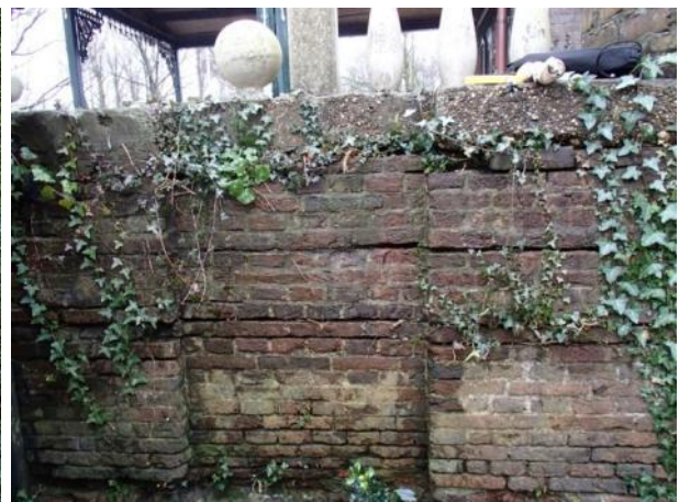
Figuur 7.12: Horizontale scheuren in het metselwerk
