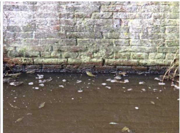
Figuur 7.4: Uitgesleten voegen op de waterlijn
