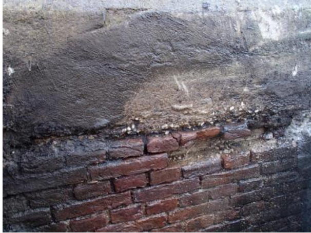
Figuur 7.7: Metselwerk buitenzijde kolkwand (put B)
