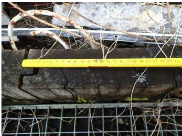
Figuur 4.9: Damwandplank 270 x 70 (b x d).
