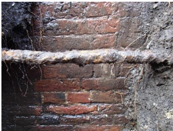
Figuur 7.9: Trekstang aan de buitenzijde achter de kolkwand
