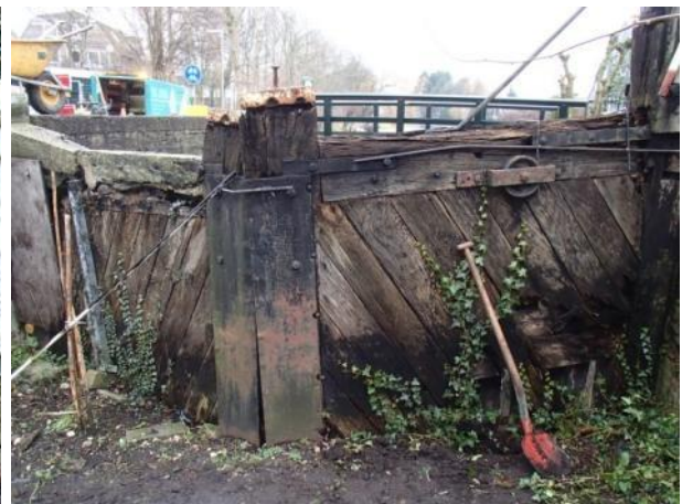
Figuur 7.16: Restanten sluisdeuren in het benedenhoofd
