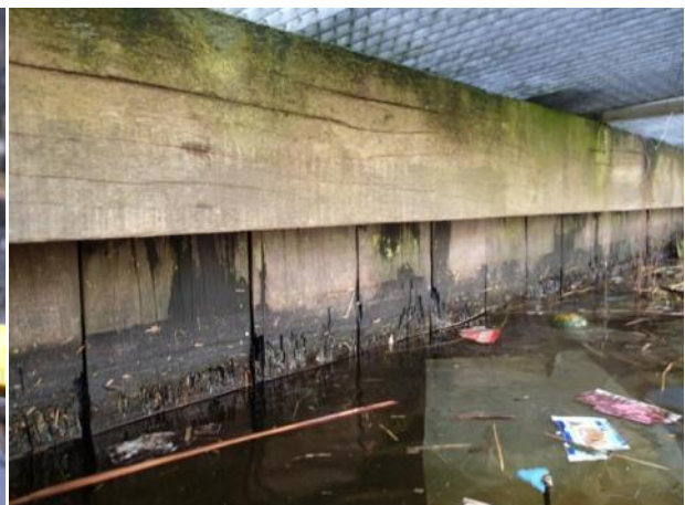
Figuur 4.6: Insnoering op waterlijn circa 5 mm.
