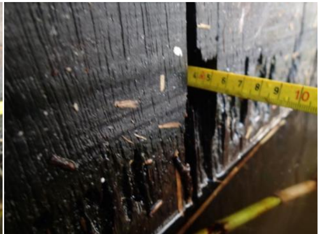
Figuur 4.8: Insnoering op messing- en groefverbinding tot maximaal 50 mm.
