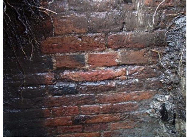
Figuur 7.8: Voegen metselwerk buitenzijde hard (put B)
