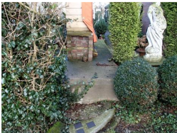
Figuur 7.11: Kop van het bovenhoofd oostzijde, door derden geplaatste bouwwerk op de sluis
