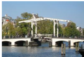
Magere brug Amsterdam
