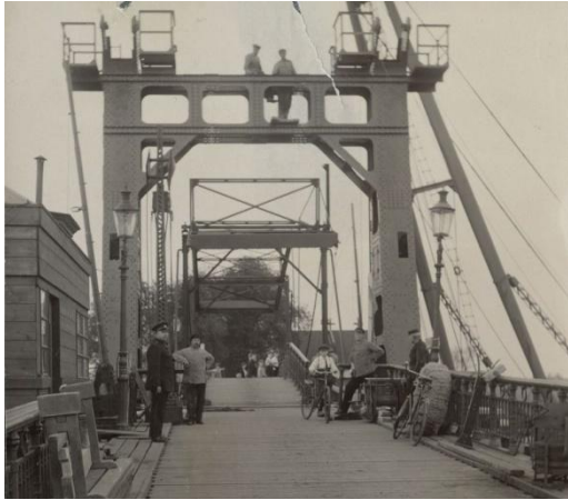
De Zaanbrug krijgt een nieuwe bovenbouw en wordt geëlektrificeerd.
