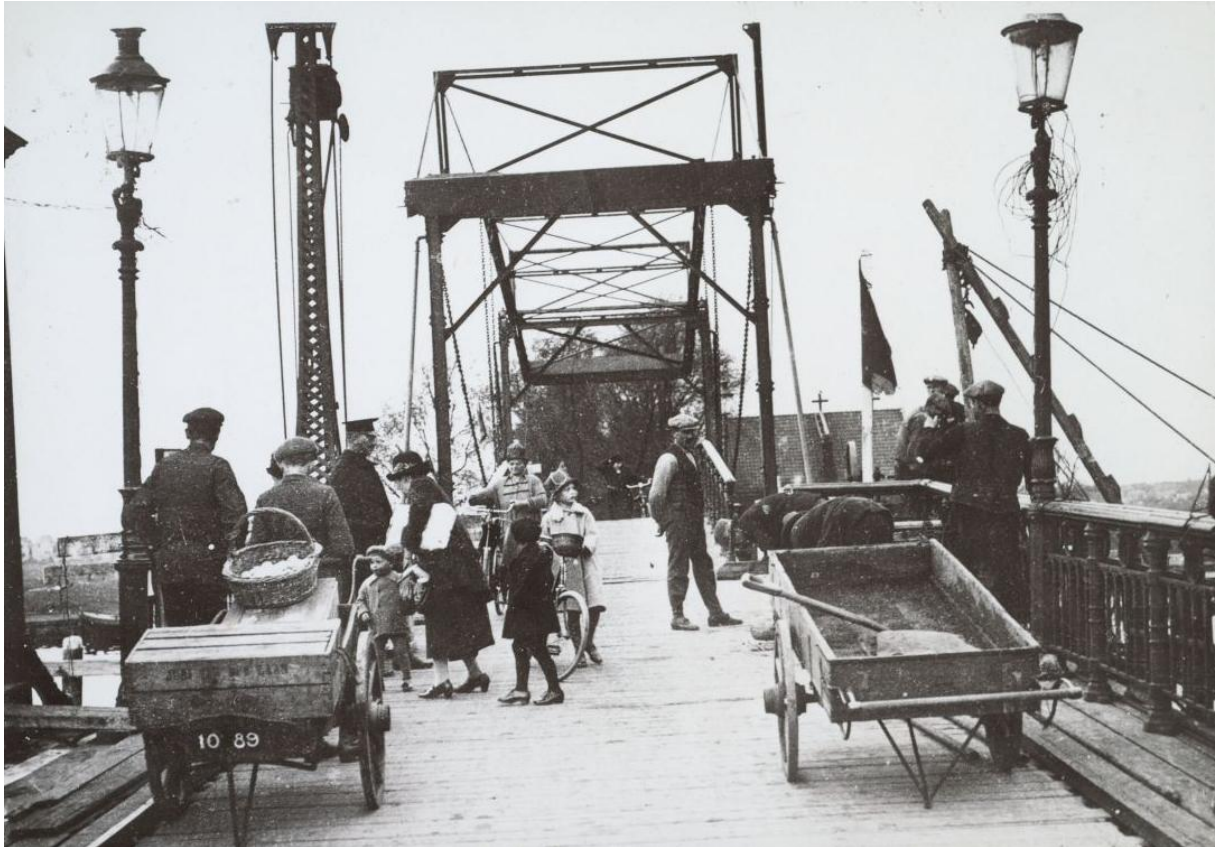
Bouw van het nieuwe beweegbare gedeelte van de Zaanbrug in september 1926.
