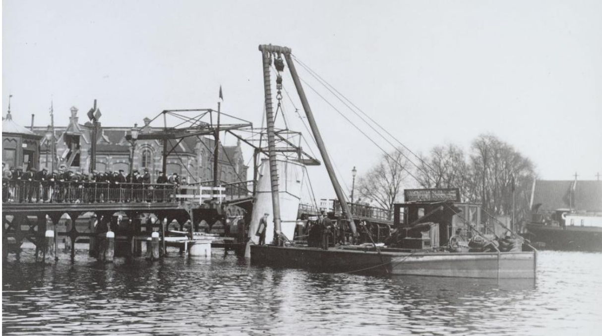
Hier wordt een pijler voor de nieuwe brug geplaatst. De aannemer had veel problemen met deze pijlers.
