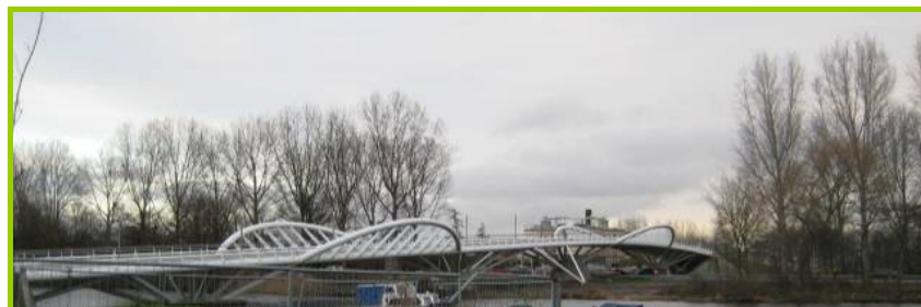
Foto 5 Busbrug De Vlinder
