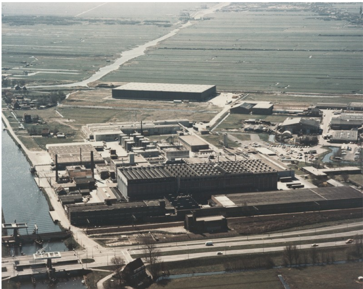
Luchtfoto Linoleum – Krommenie – geen datering of andere opmerkingen
