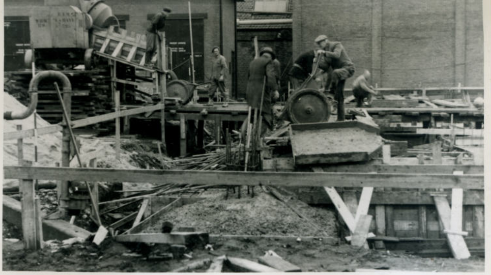
Papiermach: gebouw PM II. Betonstorten eerste stiepen.
