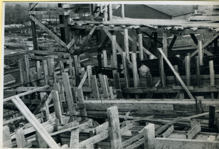
Bekisting op dak PM II gebouw.
