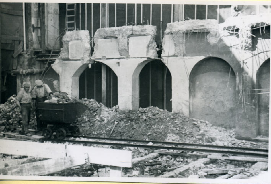
Sloopwerk voor nieuw turbinegebouw
