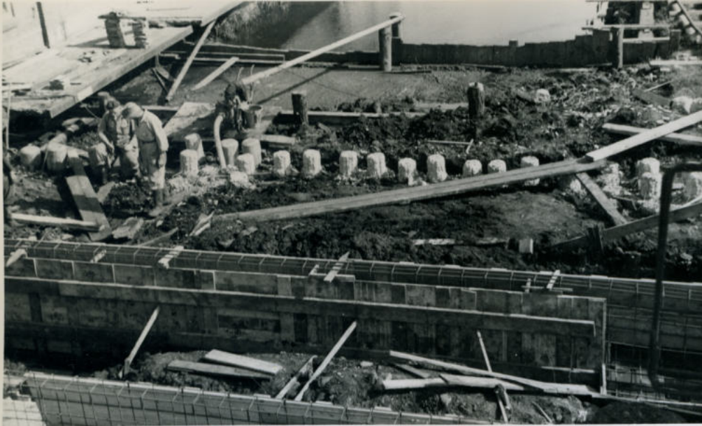
Papiermach: gebouw PM 11. Fundatie buitenste rij beton opzetten
