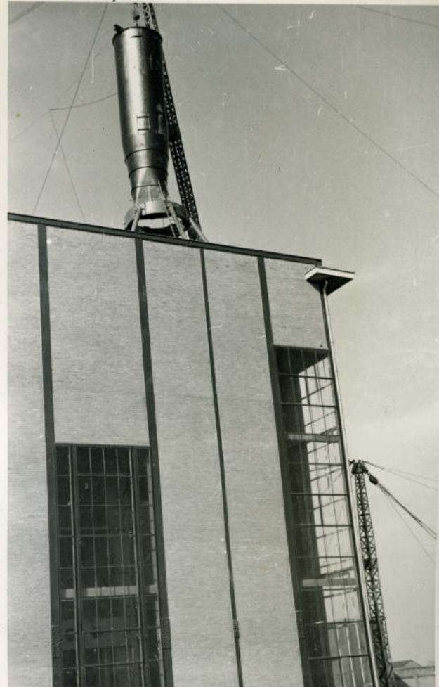
Ketel 8. De schoorsteen gaat omhoog.
