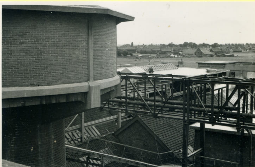
Op achtergrond vernieuwing dak PM 8 en 10.
