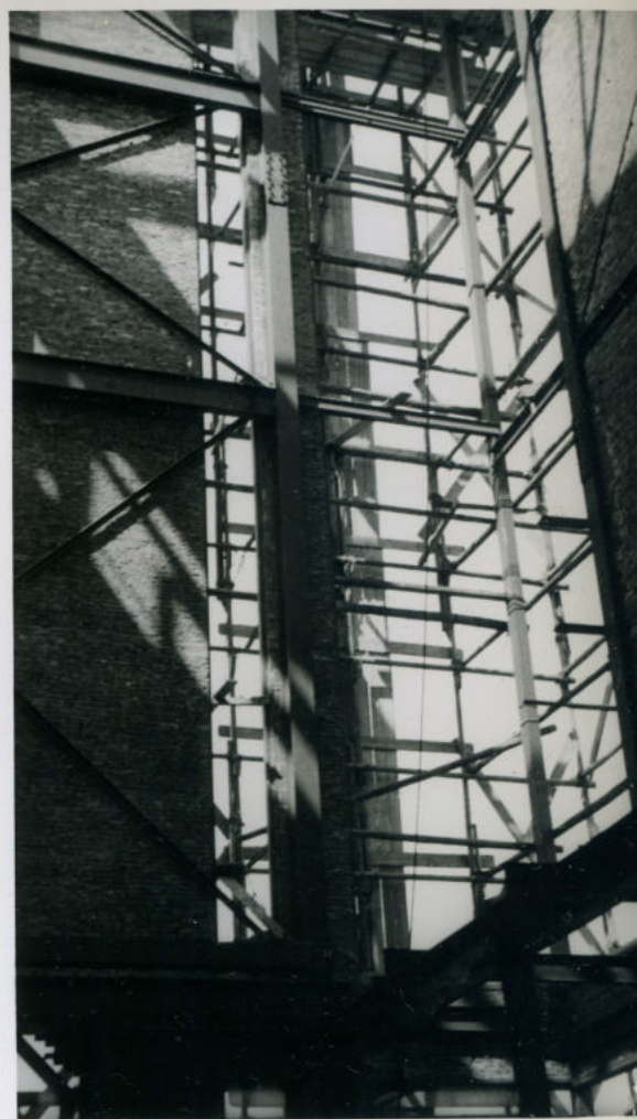
Ketel 8. Staalconstructie liftschacht
