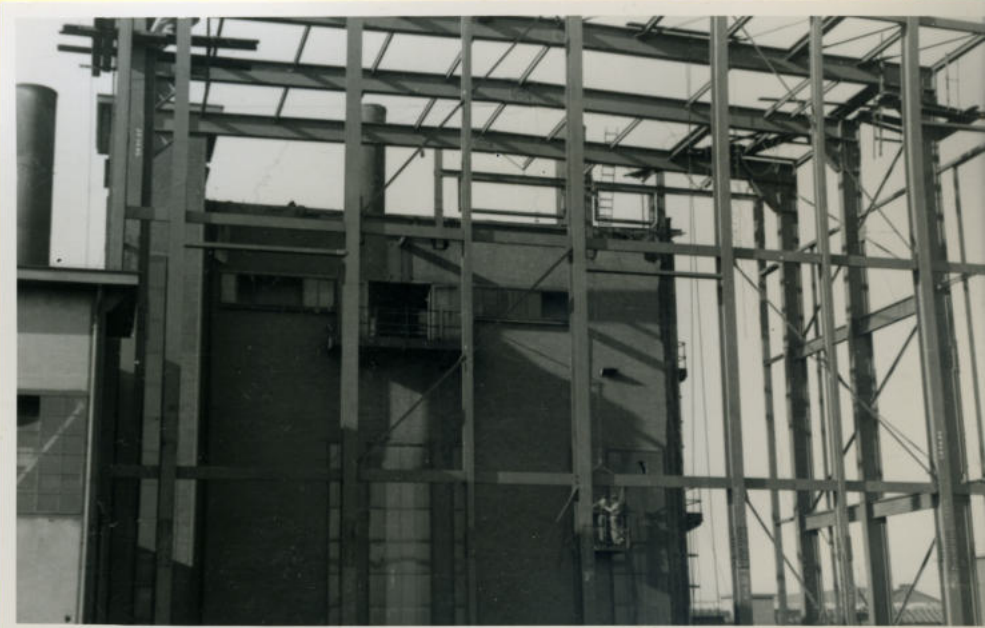
Ketel P. Opbouw staalconstructie.
