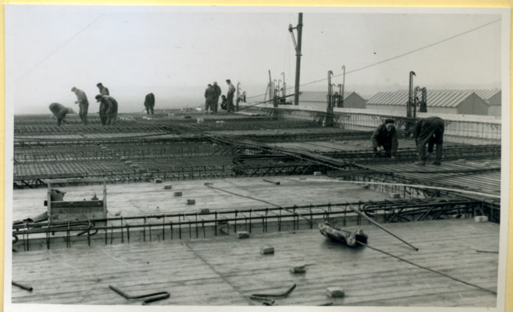
Papiermach: gebouw PM II. Bekisting en Vlechtwerk.
