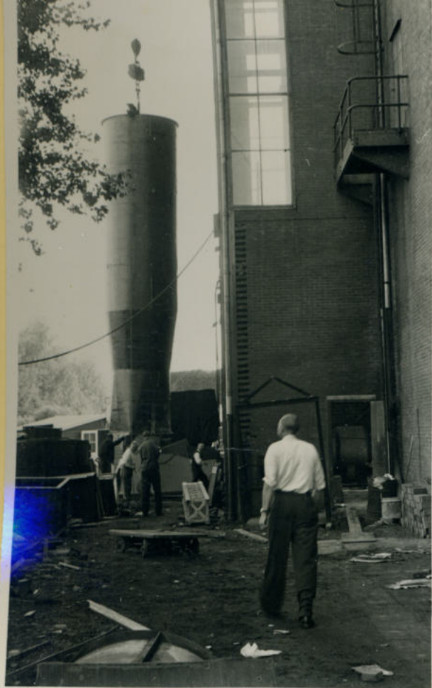
Ketel 8. De schoorsteen gaat omhoog.
