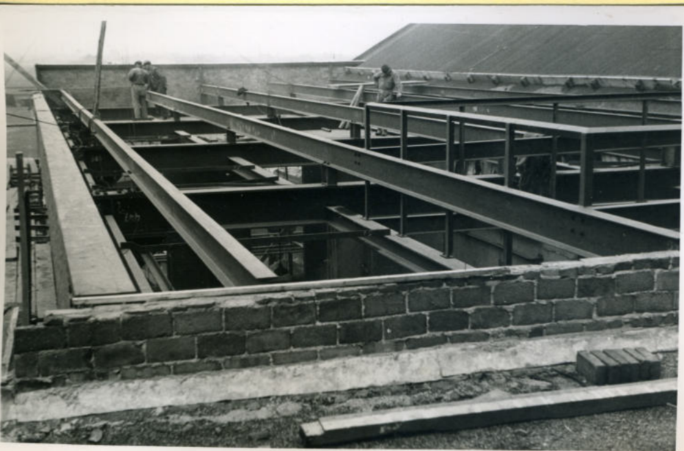
Turbinegebouw. Staalconstructie.
