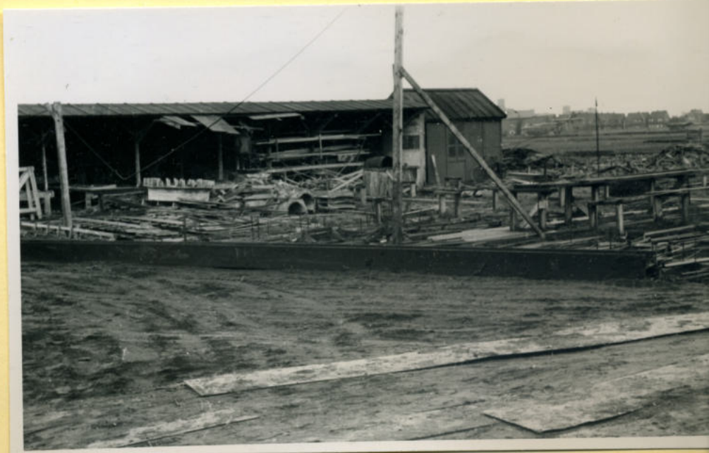
Werkterrein Wernink's Beton bij.
