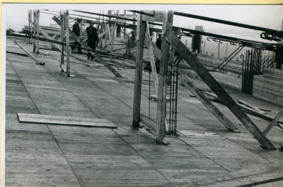
Bekisting plafond PM II gebouw.
