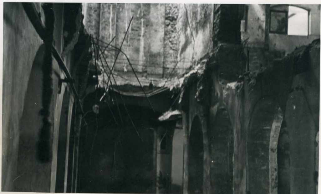
Weg te slopen ruimte, economiser voor Ketel 4.
