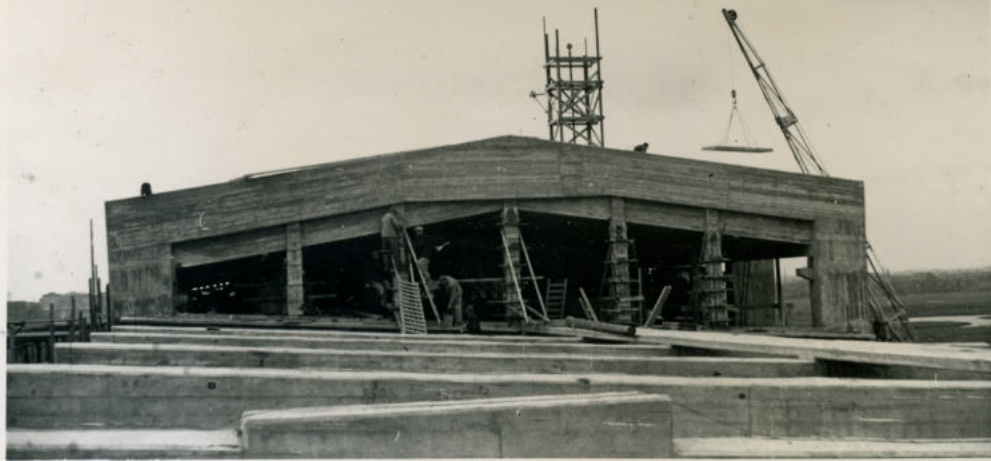
Genomen vanaf dak materij PM II, 1 e spant / op: mach: hal
