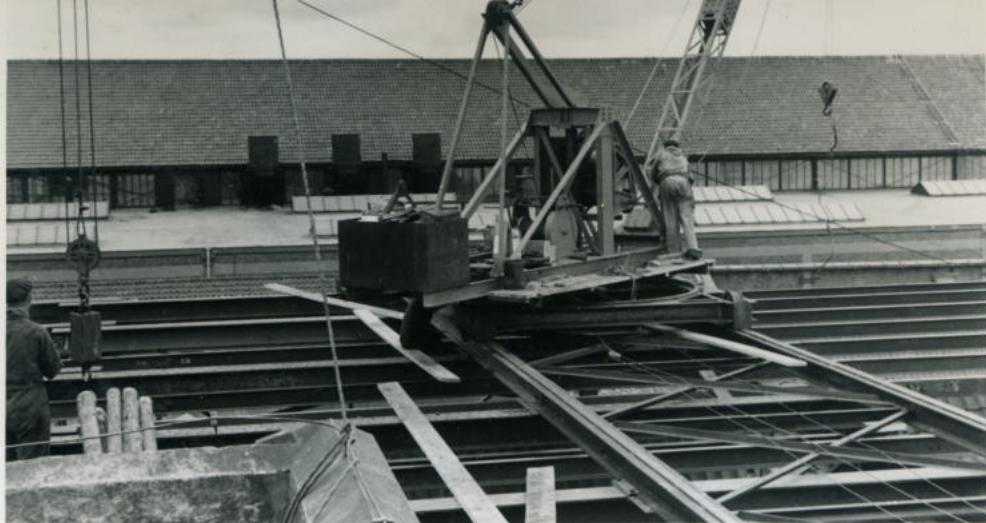
Montage staalconstructie boven PM 8 en 10.
