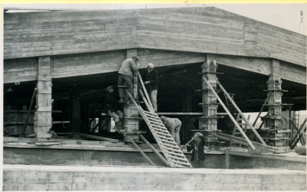
Genomen vanaf dak materij PM II, hangstijlen voor 10 M.-vloer.
