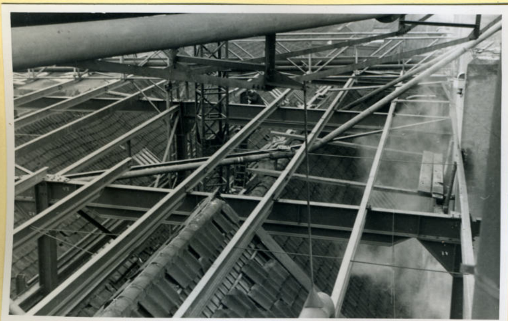
Staalconstructie boven PM 8 en 10.
