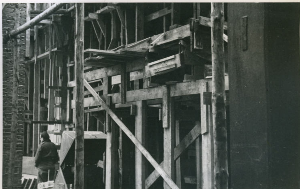
Turbinegebouw. Bekisting turbinefundatie.
