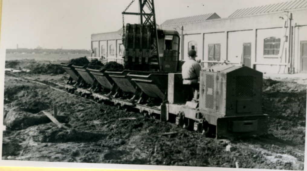
Ontgravingen voor gebouw PM 11. (19/10 '50)
