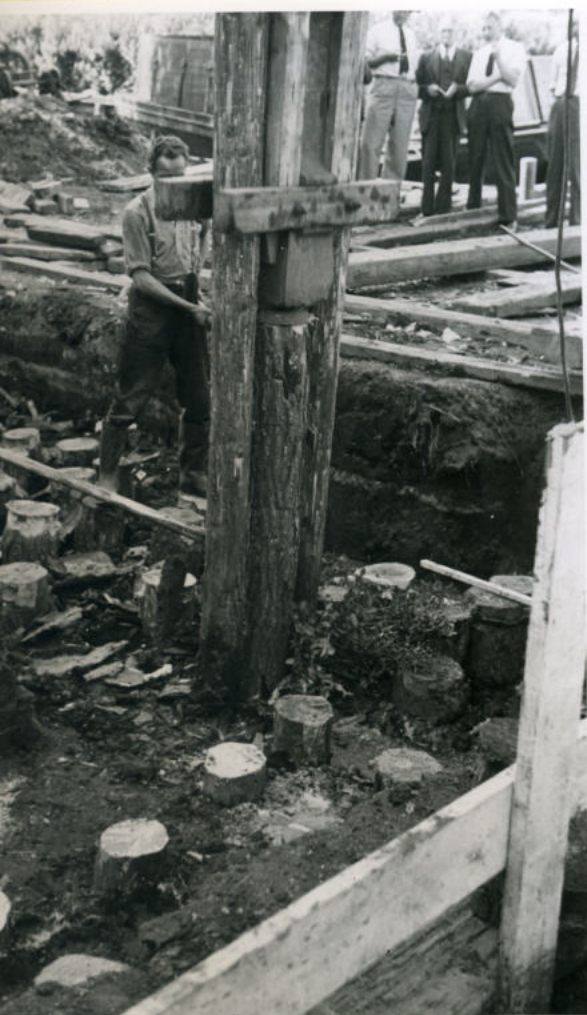
Ketel 8. de laatste paal.
