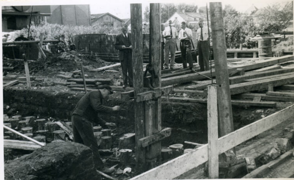
Ketel 8. de laatste paal wordt nagemeten..
