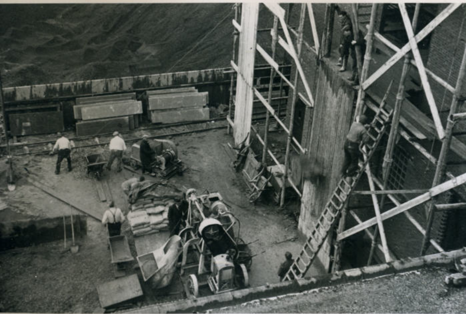
Turbinegebouw reeds in de steigers.
