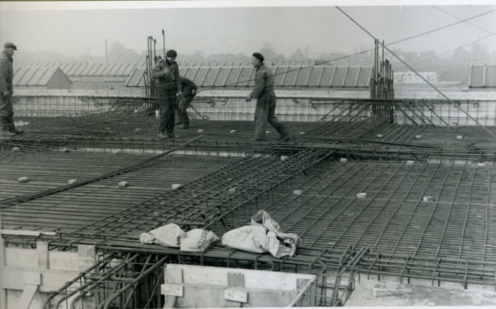
Papiermach: gebouw P.M. II. Bekisting en Plechtwerk.
