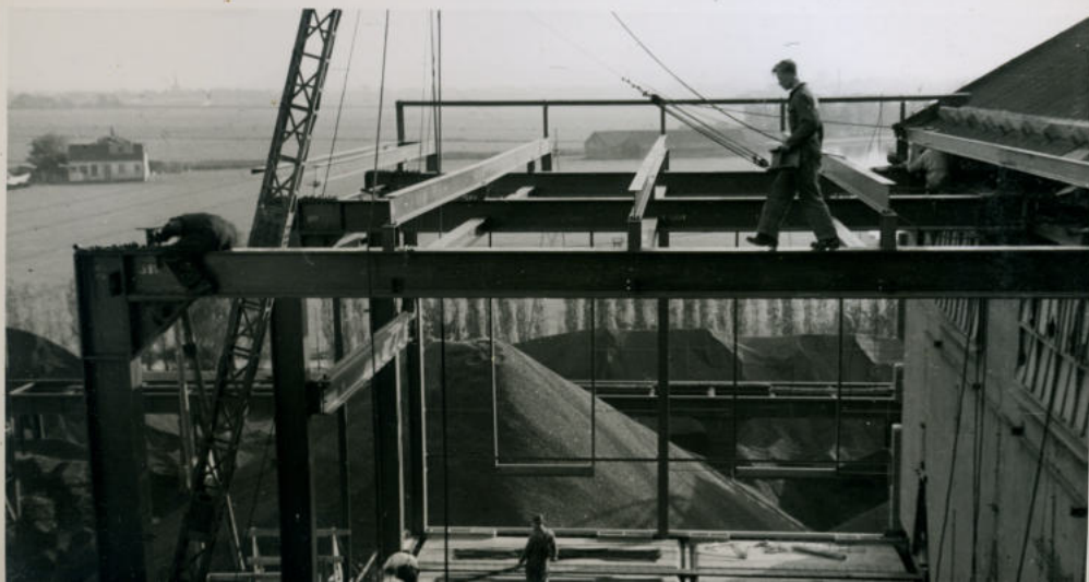
Turbinegebouw. wandeling over de spanten.
