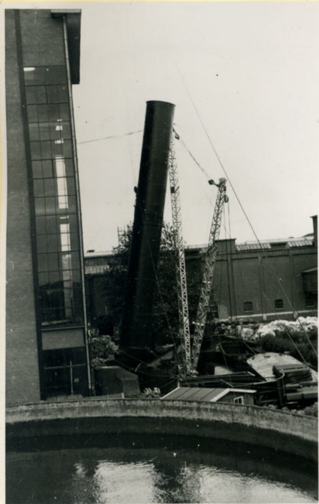
Ketel 8. De schoorsteen gaat omhoog.
