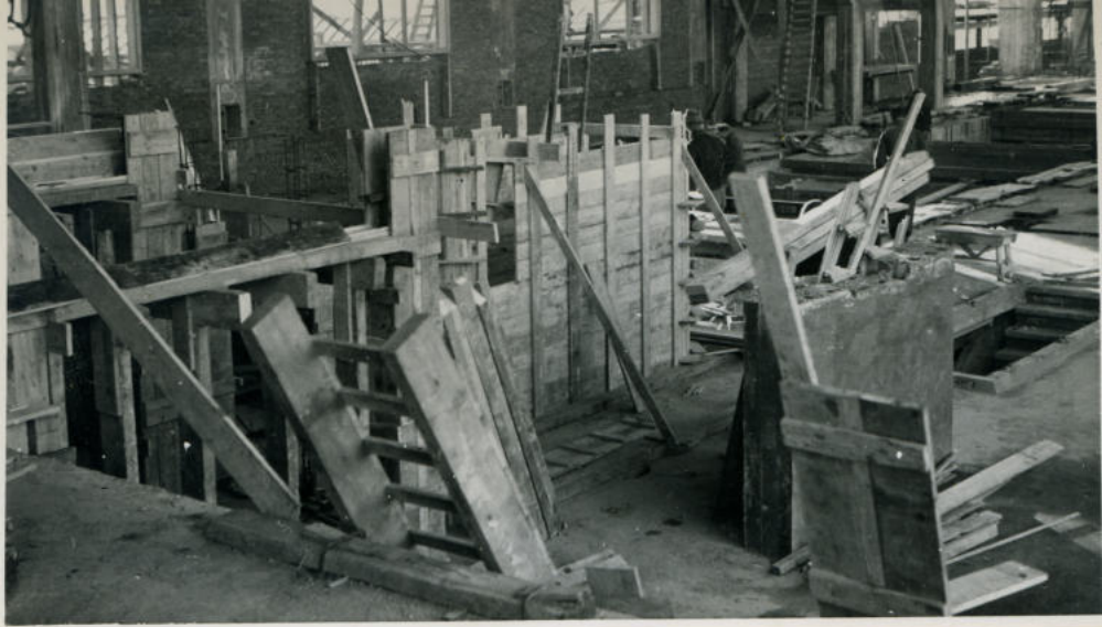
3.5 M.- vloer, bekisting Landvangers PM II.
