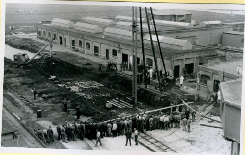
De eerste paal voor gebouw PM 11. (19/10 '50)
