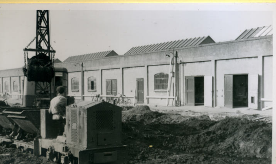
Ontgravingen voor gebouw PM II.
