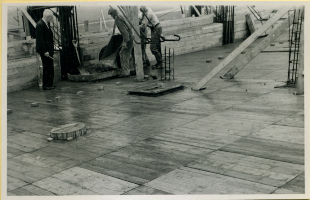
Het gieten van spantbenen PM II gebouw.
