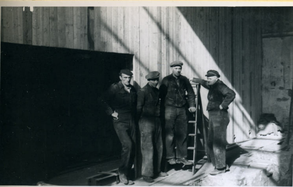
loodwand naast Ketel 5.
