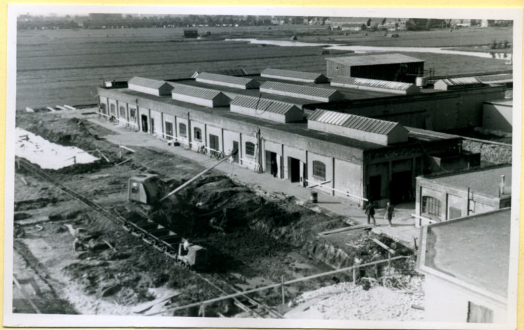
Ontgravingen voor gebouw PM II.
