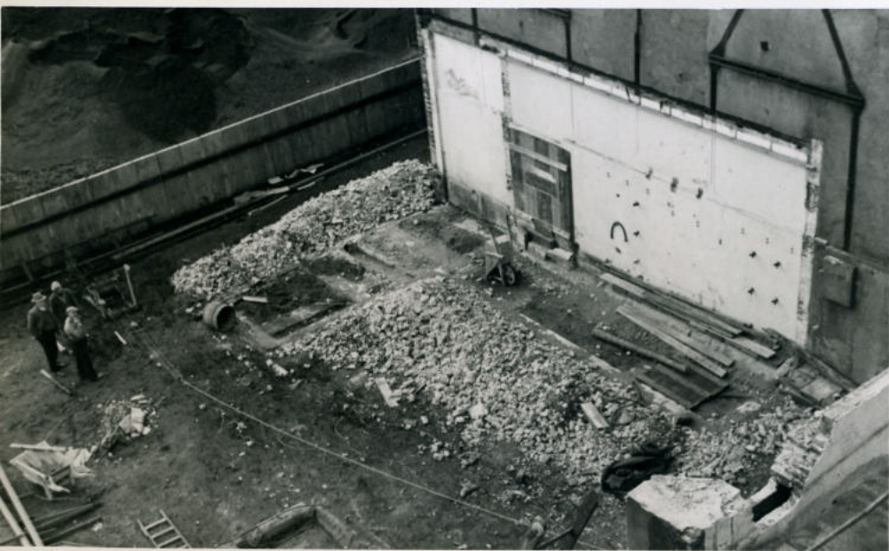
Sloopwerk voor nieuw turbinegebouw.
