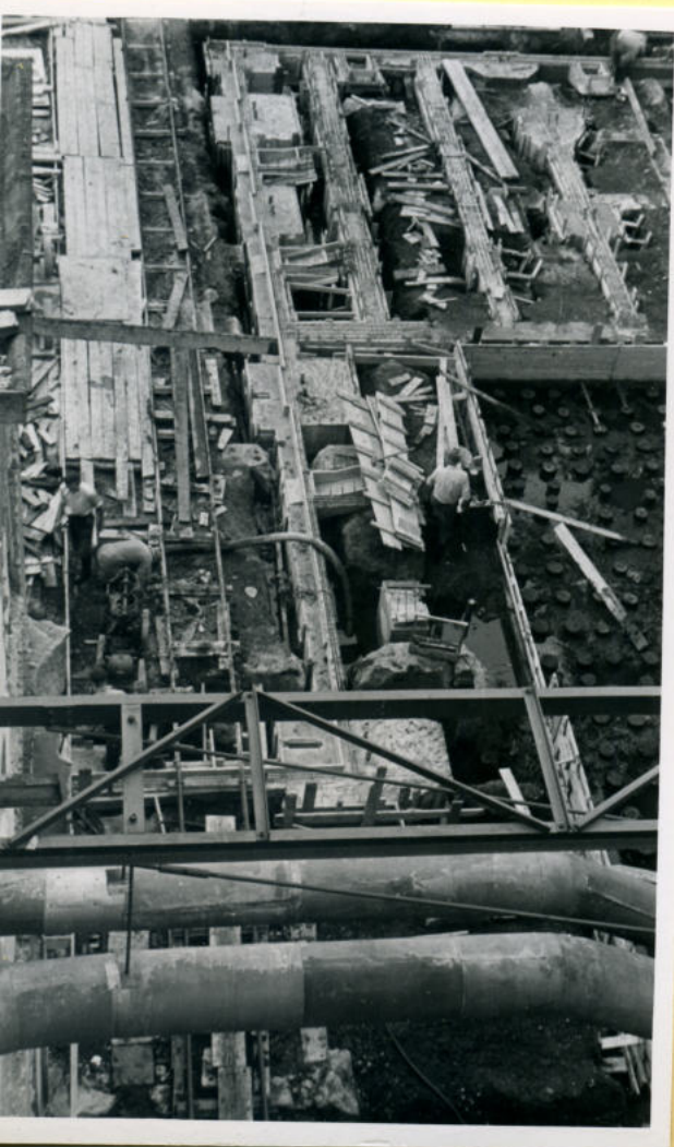
Paal en betonfundatie turbinegebouw
