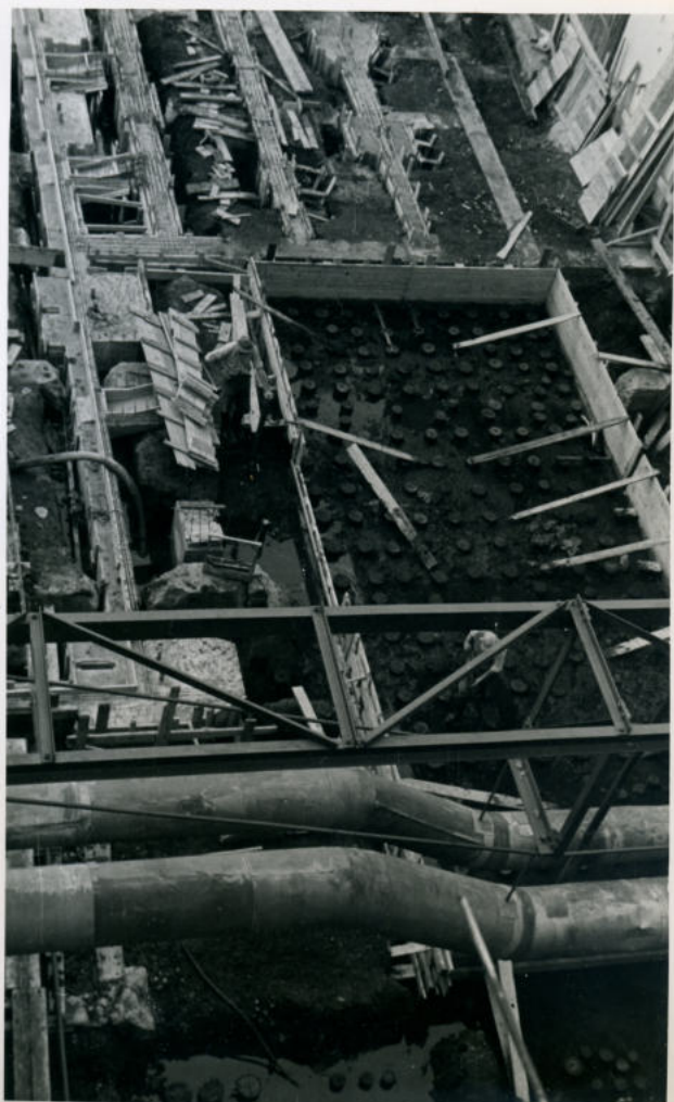
Paal en betonfundatie turbinegebouw
