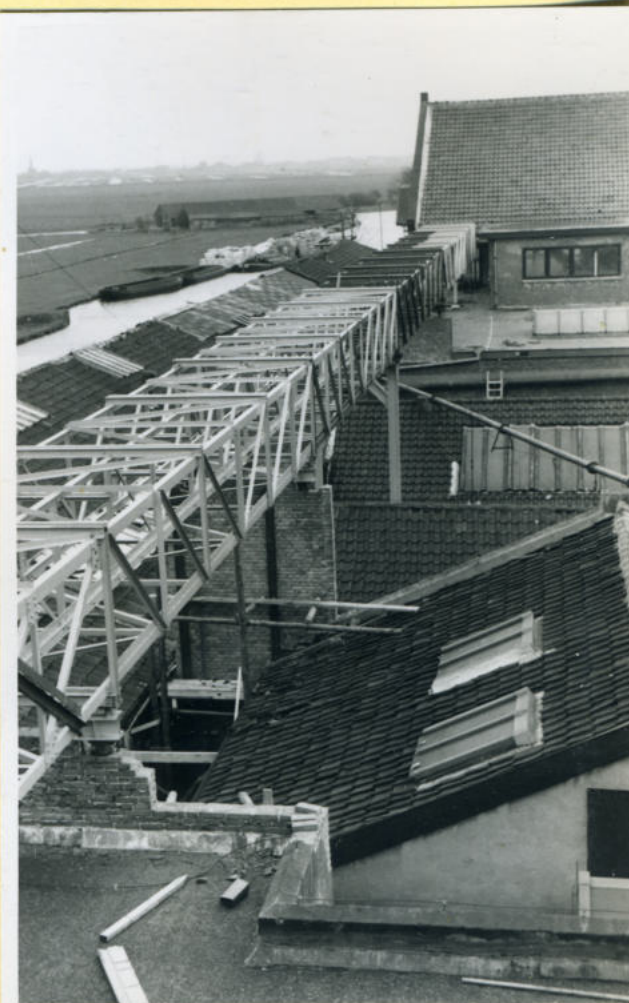
Pijpenbrug naar PM 4.
