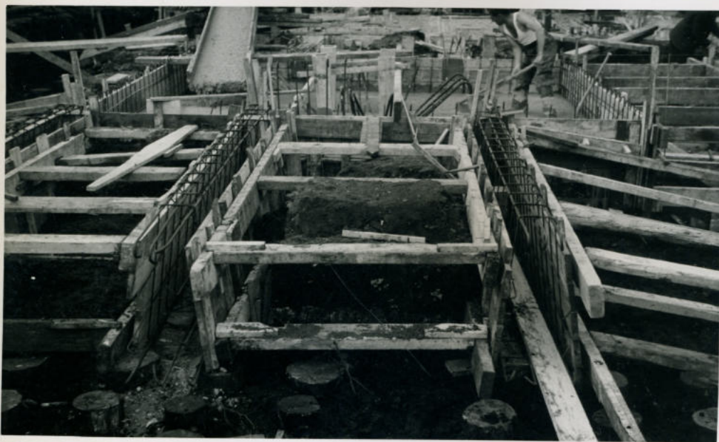
Ketel 8. Bekisting en bewapening.
