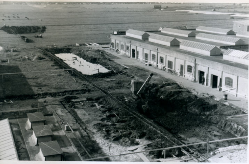
Ontgravingen voor PM II. gebouw.
