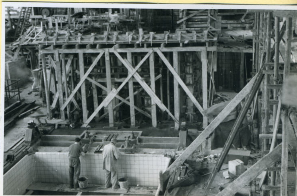
Bekisting zandvanger, op de voorgrond tegelsetters in dekkak
