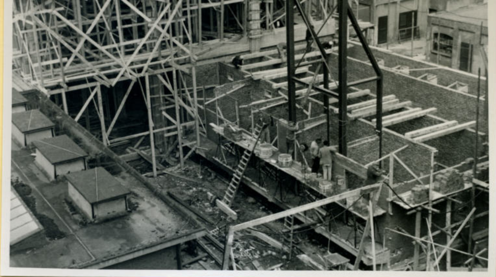
Papiermach: gebouw PM11. Opbouw transformatorgebouw.
