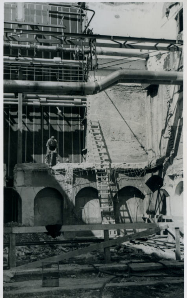
Sloopwerk voor nieuw turbinegebouw
