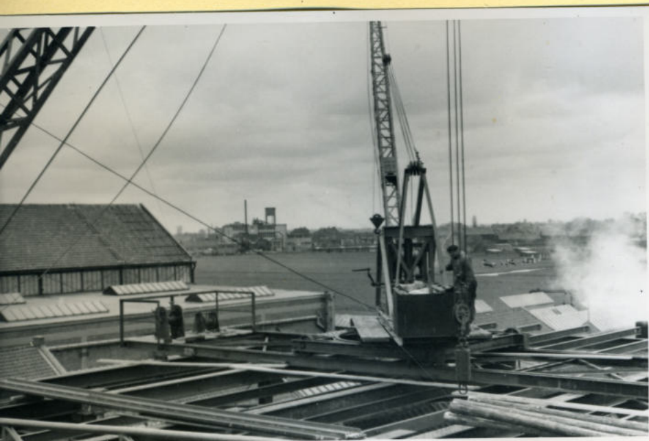
Montage staalconstructie boven PM 8 en 10.
