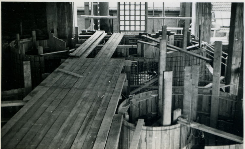
Bekisting stofkuisen. Voorgrond mengkuisen PM II. (Sec: 51).
