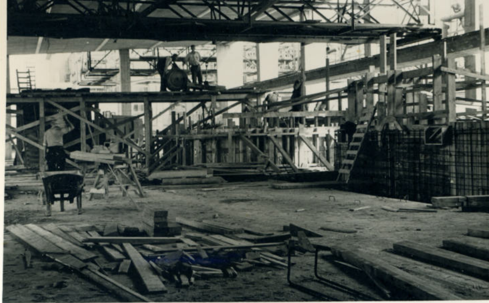
In alerij PM 11. Betonstorten vierling knip.
