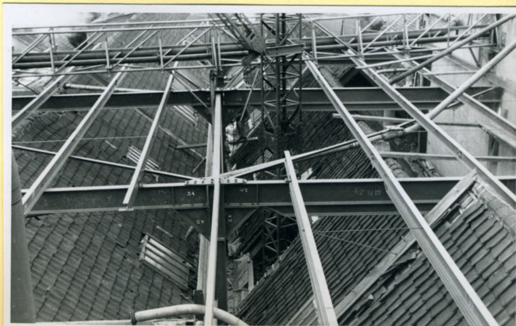
Staalconstructie boven PM 8 en 10.
