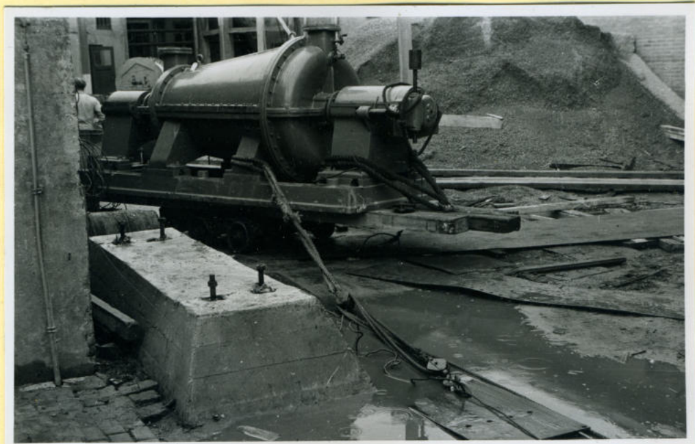
Transport van Kegelstofmolen naar halerij PM II.
