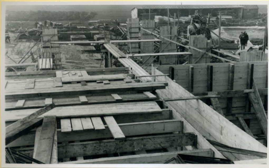
Papiermach: gebouw PM11. Bekisting en Vlechtwerk.
