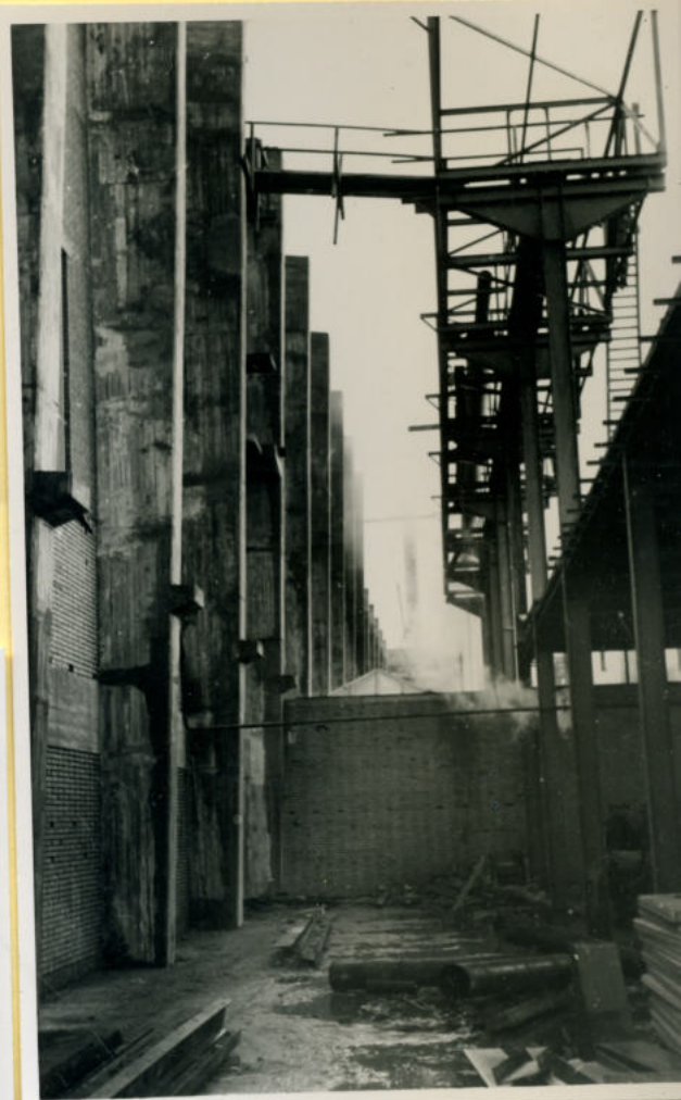
Tussentbouw PM 2 en PM 11. Kabel en pijpenbrug in aanbouw
