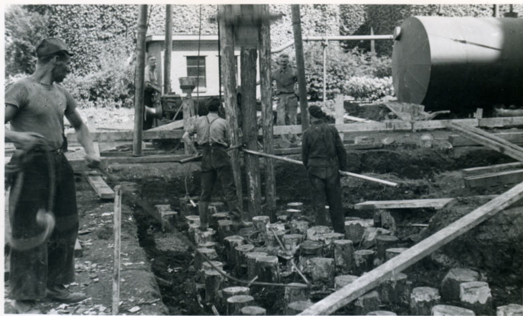
Ketel 8. de laatste paal.
