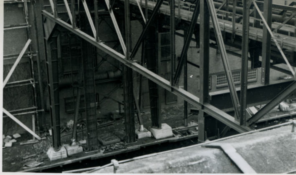
Staalconstructie pijpenbrug over vaart.
