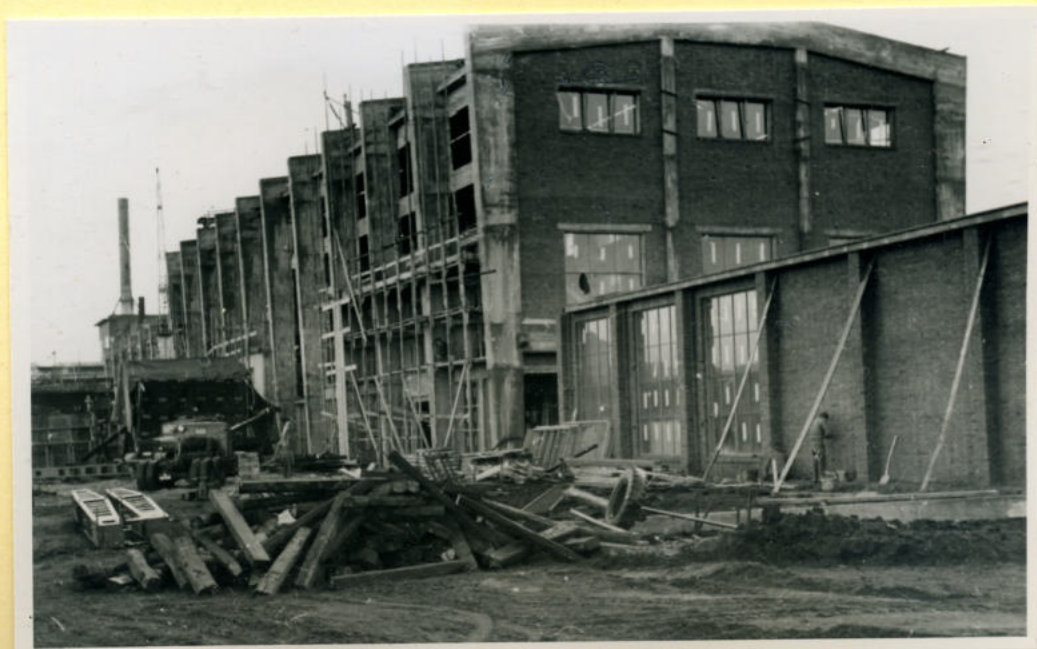
Gebouw PM 11. Links cilinder onder dekkleden.
