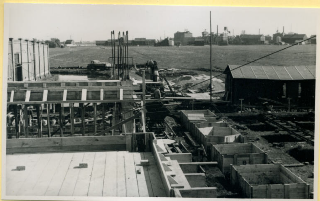
Papiermach: gebouw PM links, rechts bekisting pap: mag.
