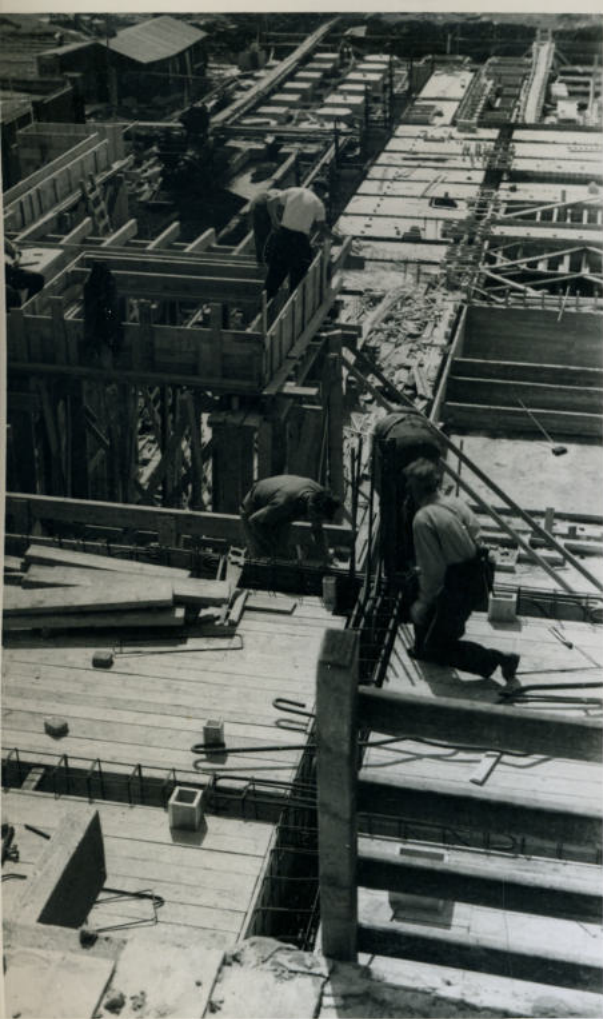
Papiermach: gebouw PM 11. Pap: mag: op achtergrond, voor bekisting 3.5 m.-vloer.
