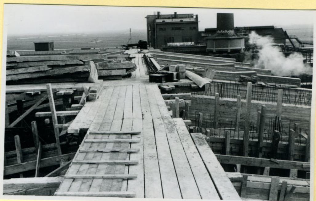
Rijbeem over dak gebouw PM II.
