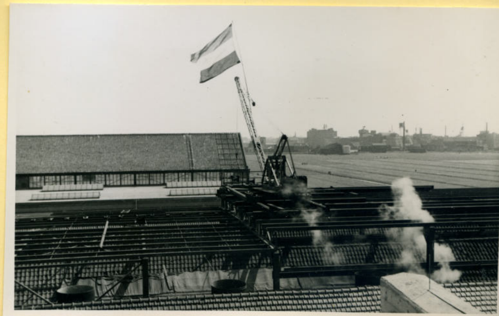
De Yzerconstructie gereed boven PM 8 en 10.
