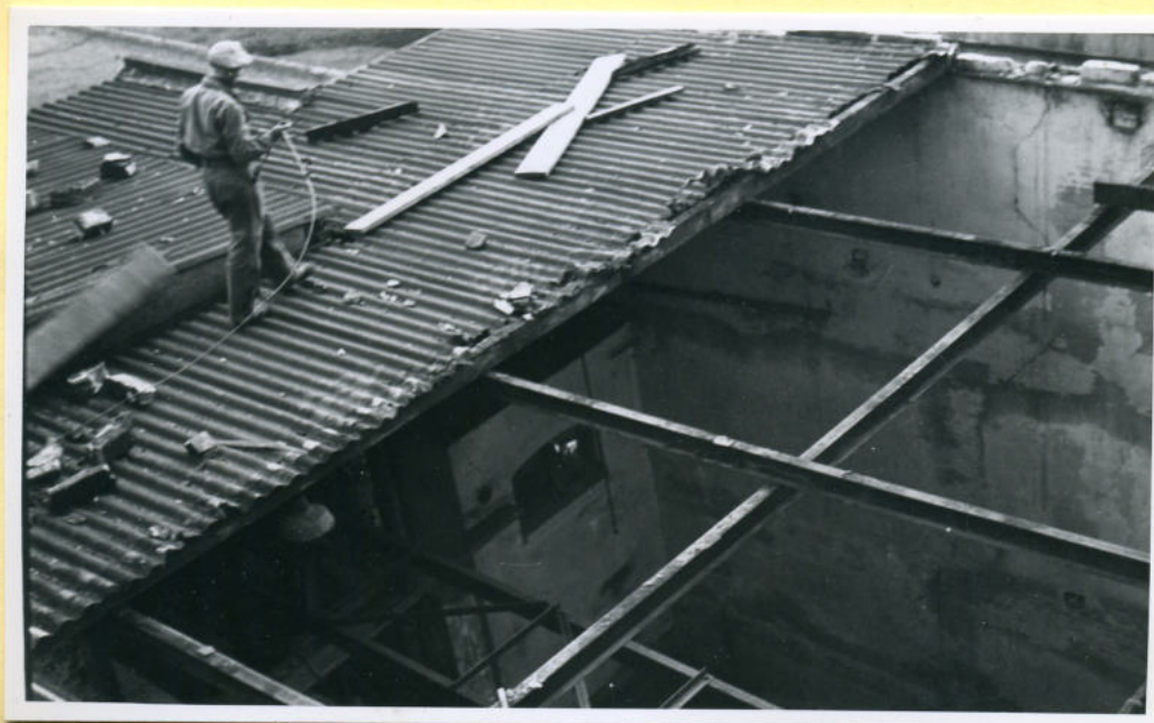
Slopen dak boven economische Ketel 4.
