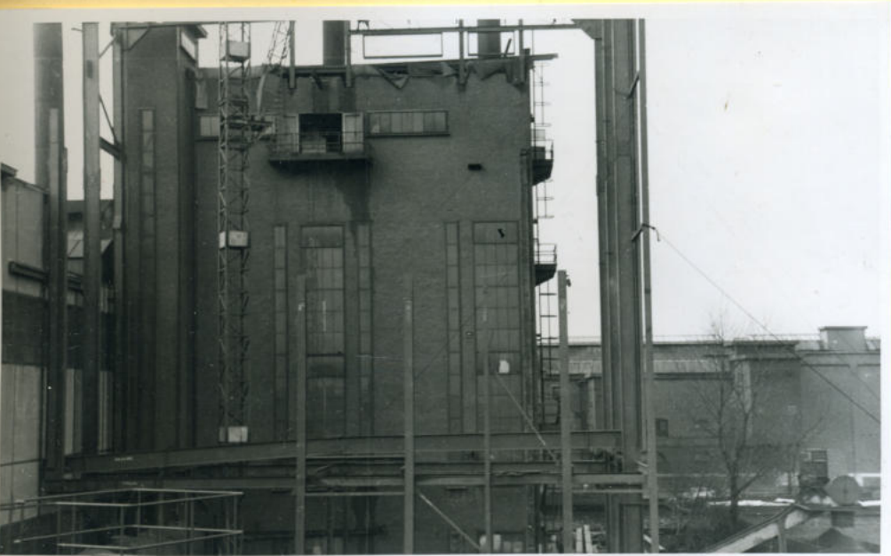
Ketel P. Opbouw staalconstructie.
