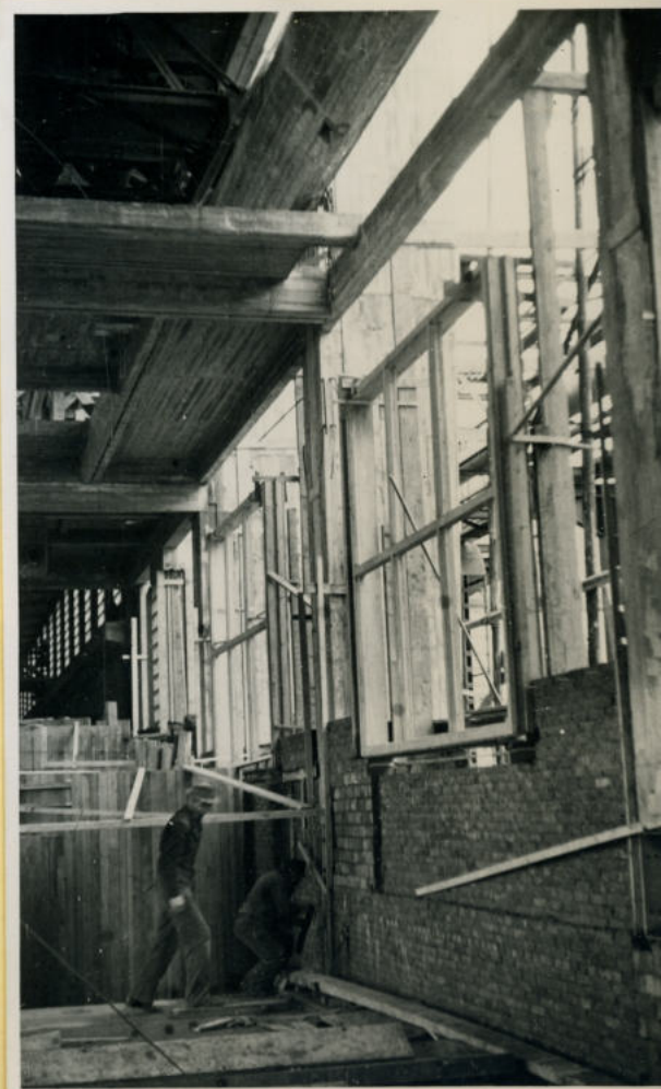
Afstellen schokbetonramen. gebouw PM11.
