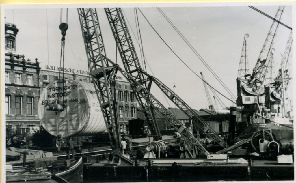
De drijvende bok met de cylinder in de takels.
