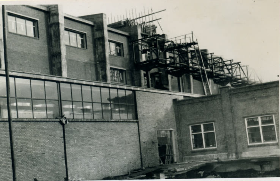
Luidgewel PM 11. In aanbouw Kabel en pijpenbrug en luchtbehandelingsgebouwtje (Febr: 52.)
