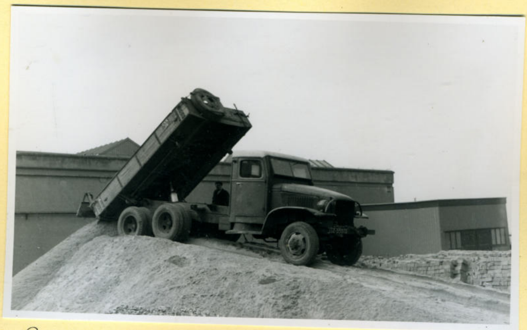
Papiermach: gebouw PM II. Zand en grintbergen.
