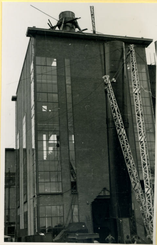
Ketel 8. De schoorsteen gaat omhoog.
