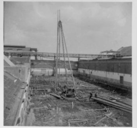
De bouw van S. No. 22. Augustus - September 1955.
