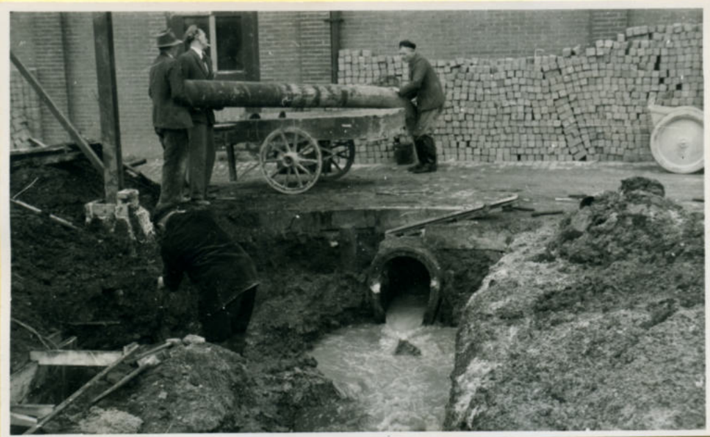
Wacofilter. Hoofduitlaat monteren.
