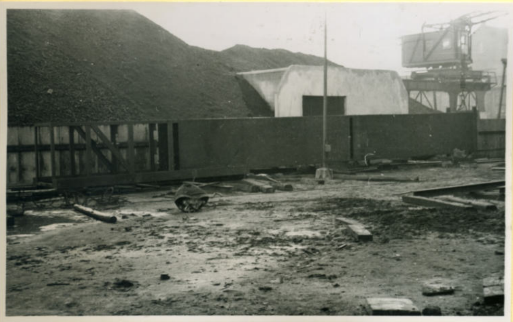
Bunhergebouwotje kolentransport Ketel 8.
