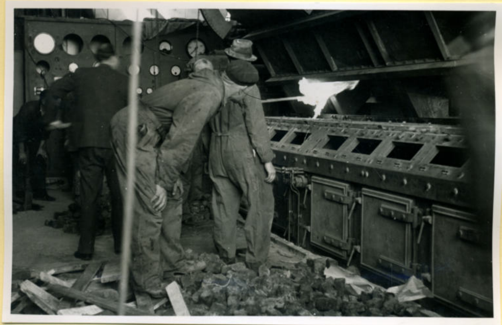
Ketel D. Droogstoken met turf.
