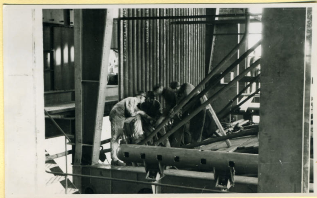
Ketel P. montage pijpen.
