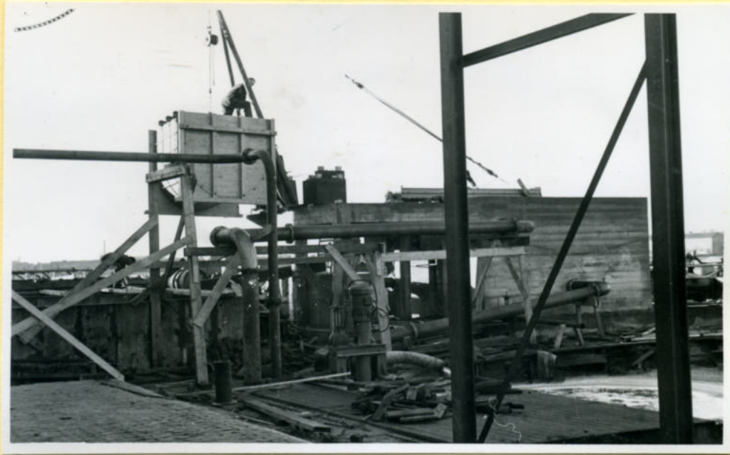
Wacofilter. Het plaatsen van de oplosbak.
