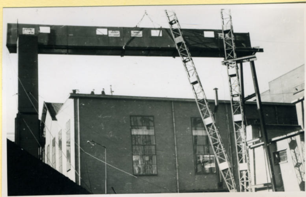
Kolentransport Ketel 8. Montage van de tunnel.
