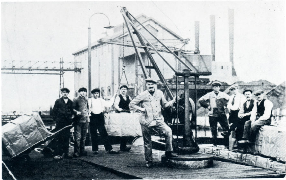
Een 'lossersploeg' aan het werk/a shift of 'unloaders' at work (1928)
