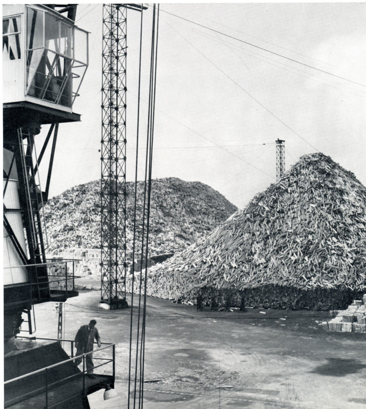
Het hout wordt via kabelbanen op de "piles" gestort.
