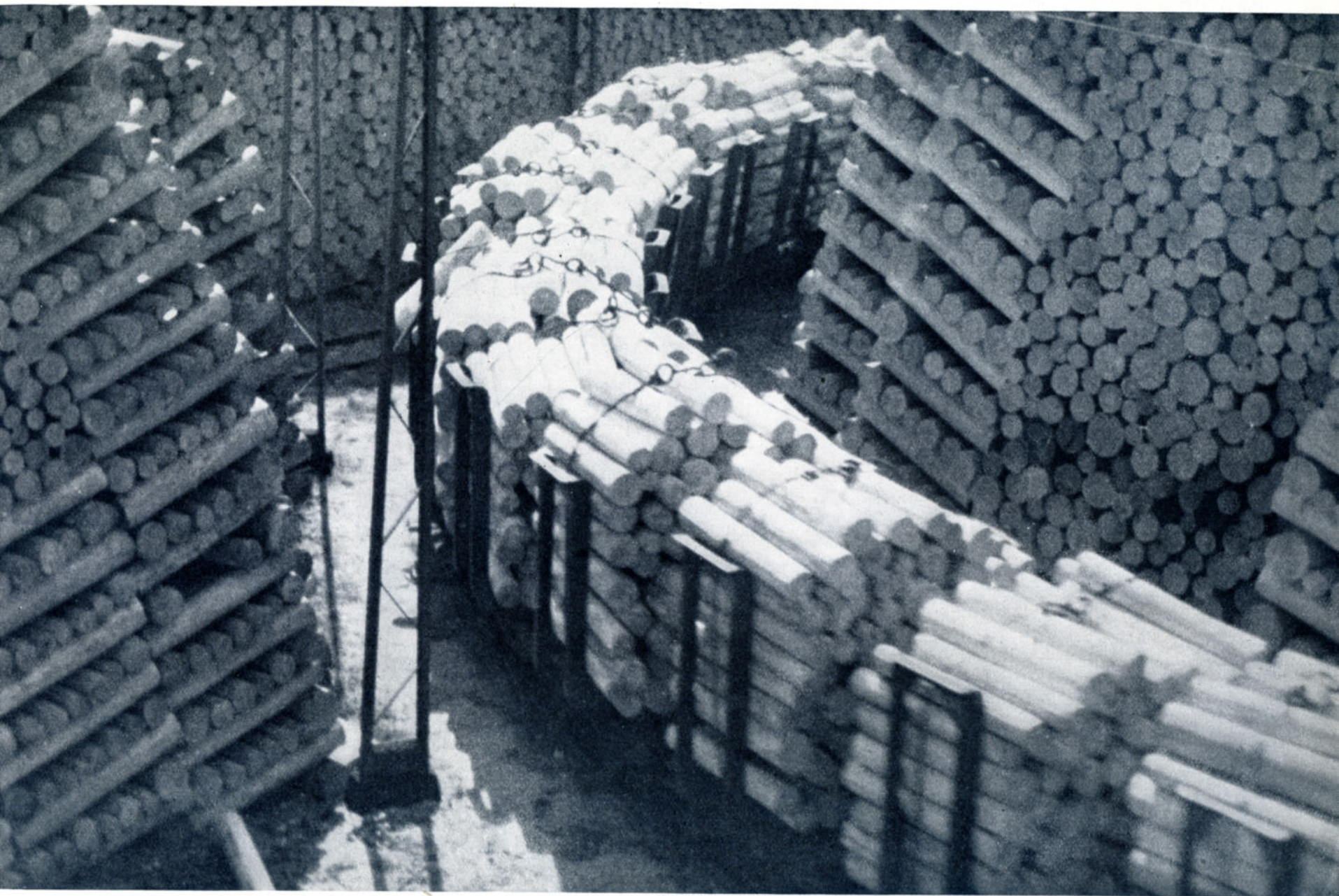
Houttransport naar de opslagterreinen per geëlectriceerd smalspoor
