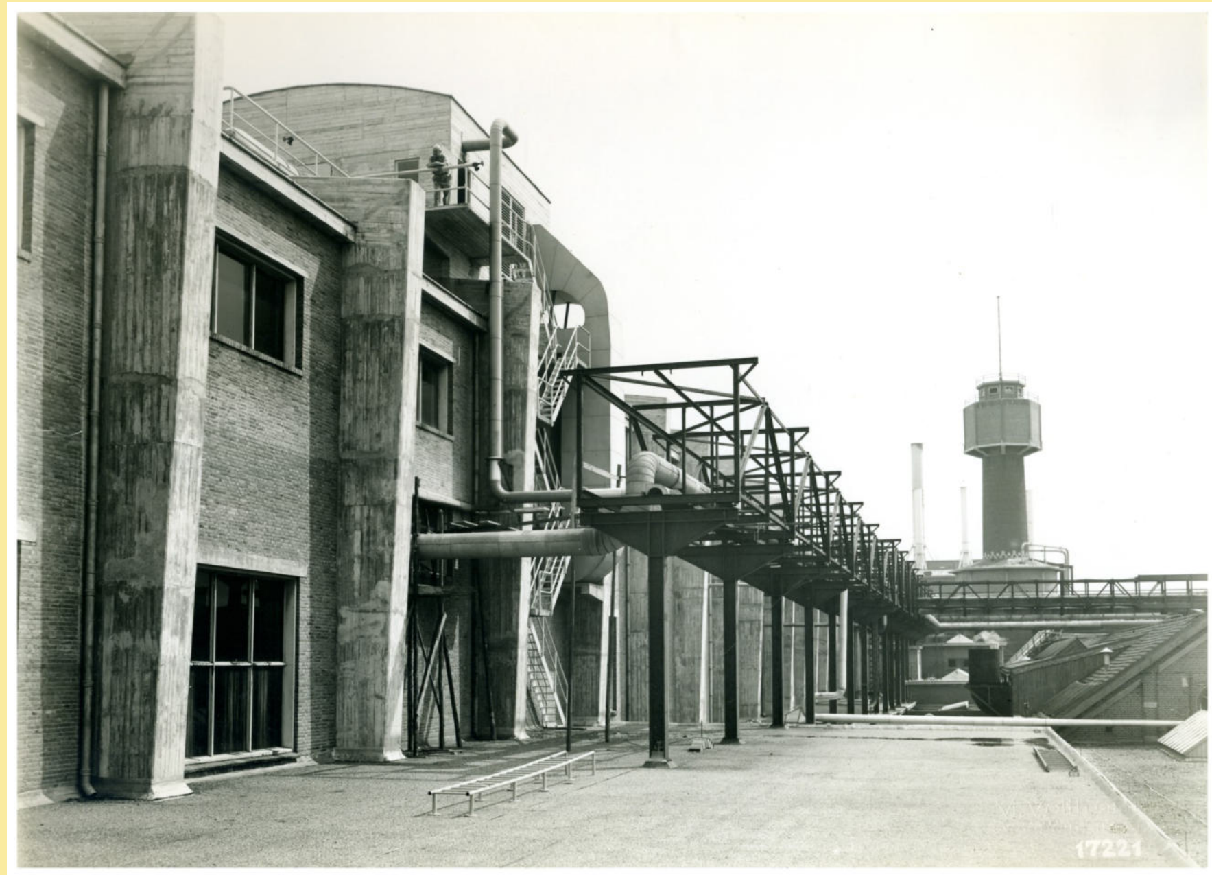
PM 11 achterzijde met pijpenbrug voor stoomleidingen
