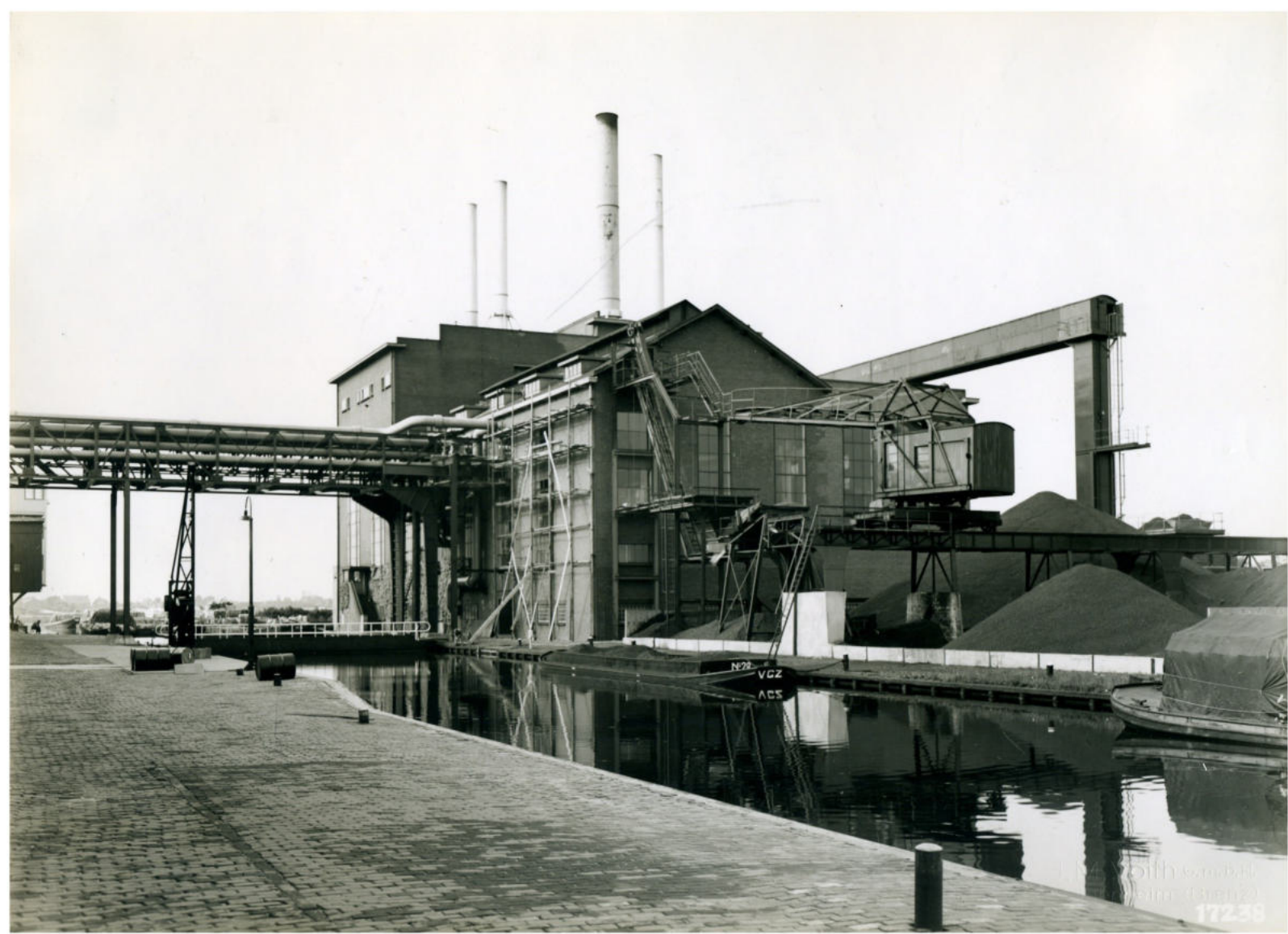
Westerveersloot met het ketelhuis, het kolenpark en de pijpenbrug Rechts de kolentransportinstallatie naar de nieuwe ketel voor PM 11
