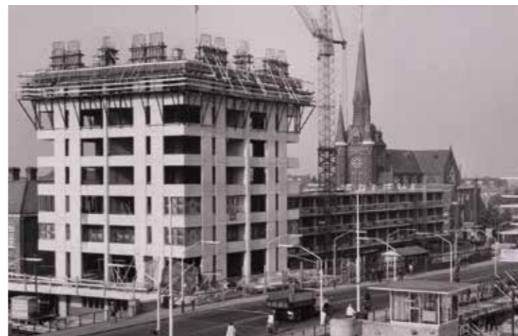
De Beatrixtoren, de flats en het winkelcentrum aan de Peperstaat in aanbouw begin jaren zestig. (Foto Bob Fleumer Aerial Photography B.V. Westzaan GAZ 22.02243)
