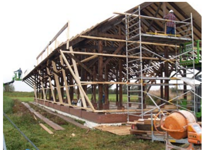
Herbouw en restauratie van de gedemonteerde houtloods
