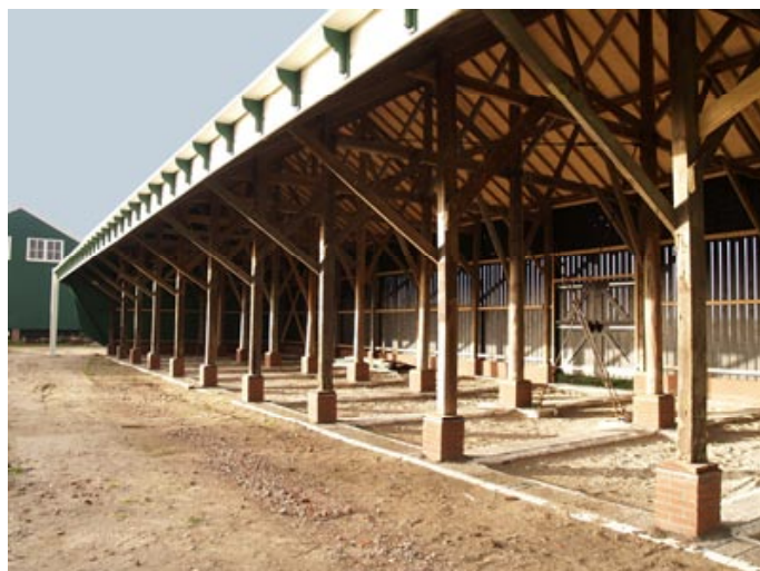
En kijkje in de binnenkant van de houtloods, nu nog leeg maar binnenkort in gebruik.
