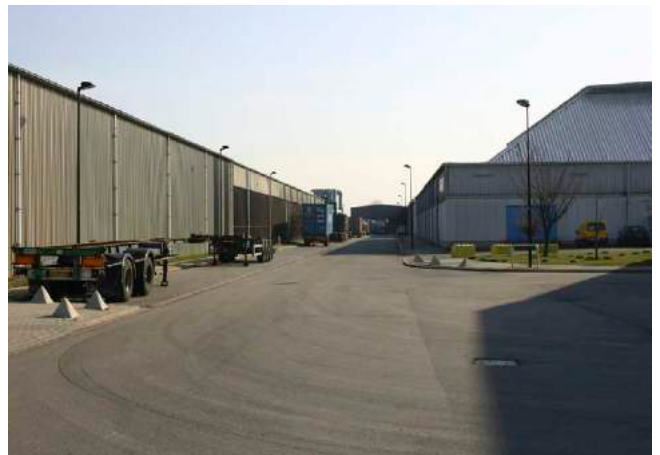
Rijshoutweg in de Achtersluispolder
