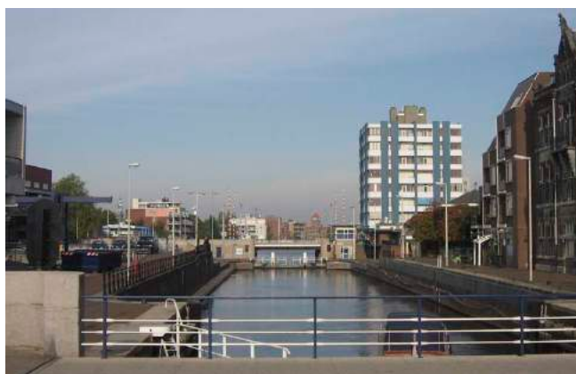
Huidige situatie sluis
