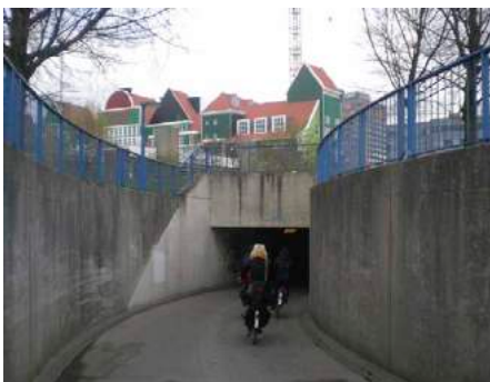
Fietstunnel bij station Zaanadam
