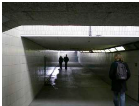
Tunnel onder de provinciale weg
