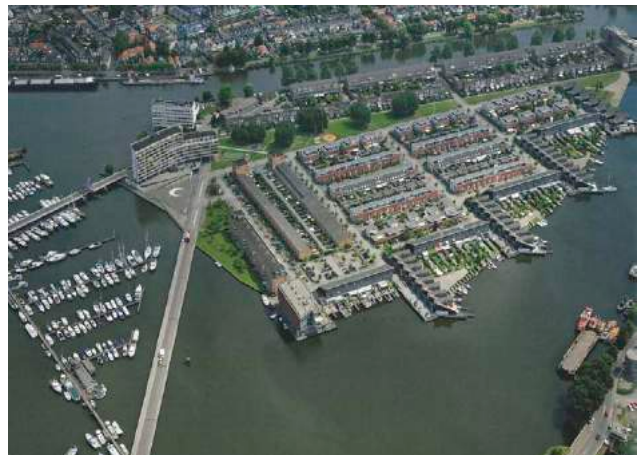
Zicht op Zaaneiland vanuit het westen
